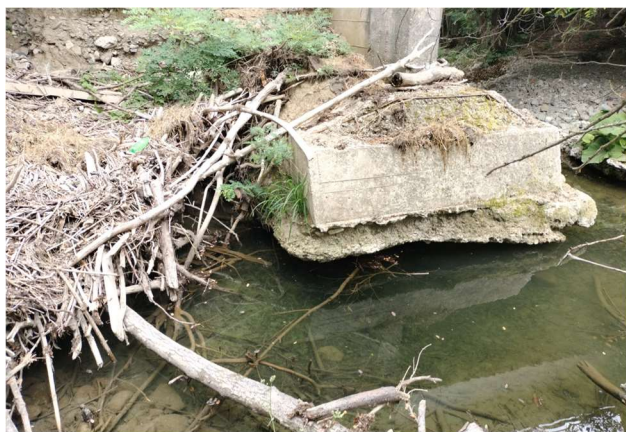
Fenomeno avanzato di scalzamento della pila e della spalla
