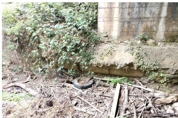
Fenomeno avanzato di scalzamento della pila e della spalla
