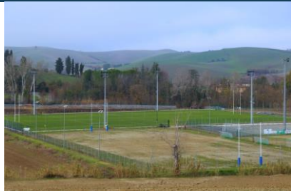
Completamento del nuovo impianto da rugby a Gambassi Terme
