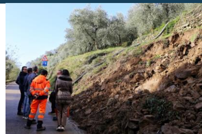
Sopralluogo a Vinci per i danni causati dal maltempo
