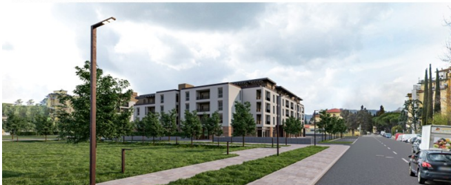
08 via dell'Acciaiole vista da nord-est
