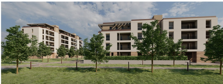
Vista da nord 07
