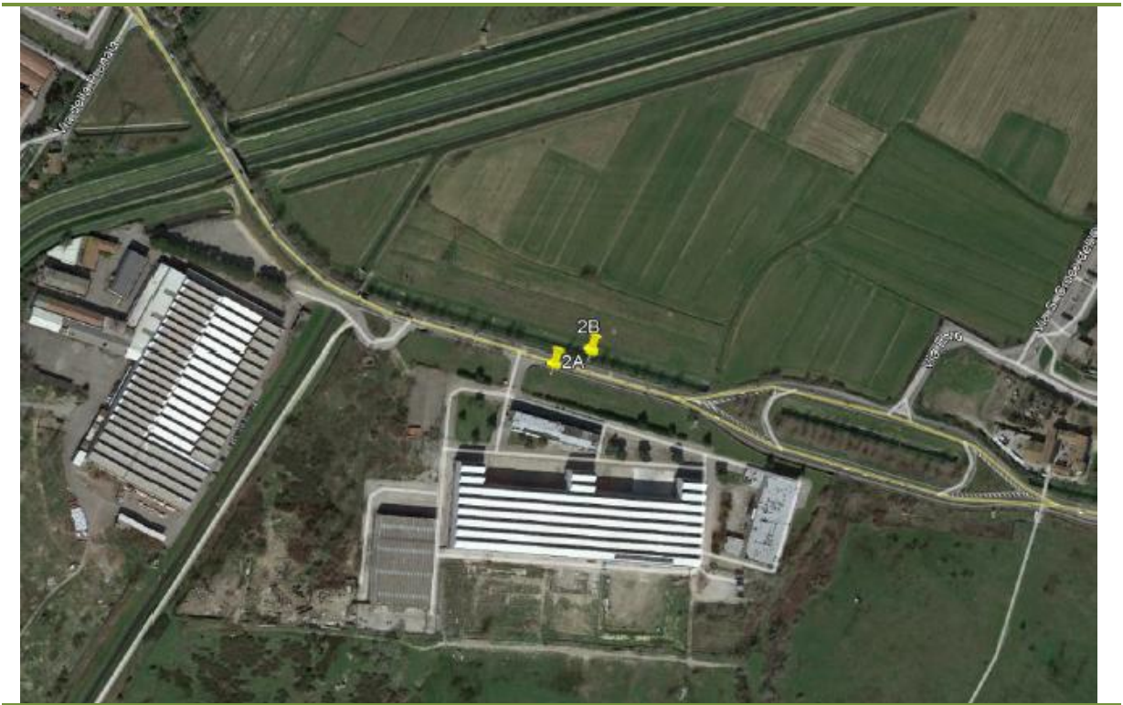
Posizione di installazione dei radar conta traffico (Aleph s.r.l. 2020)
