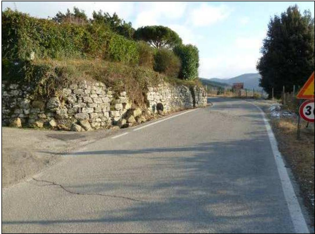
**Figura 677: dissesto su un muro a secco.**
