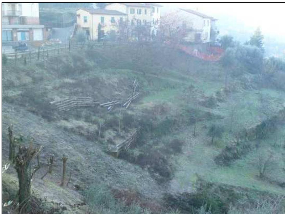
Figura 617: porzione di versante a valle della strada provinciale. Si noti la rottura di una palificata in legname.
