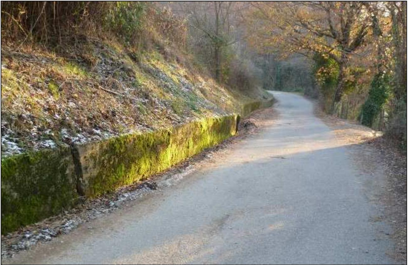
**Figura 662: avvallamenti e muro monte strada segnali della presenza di instabilità.**
