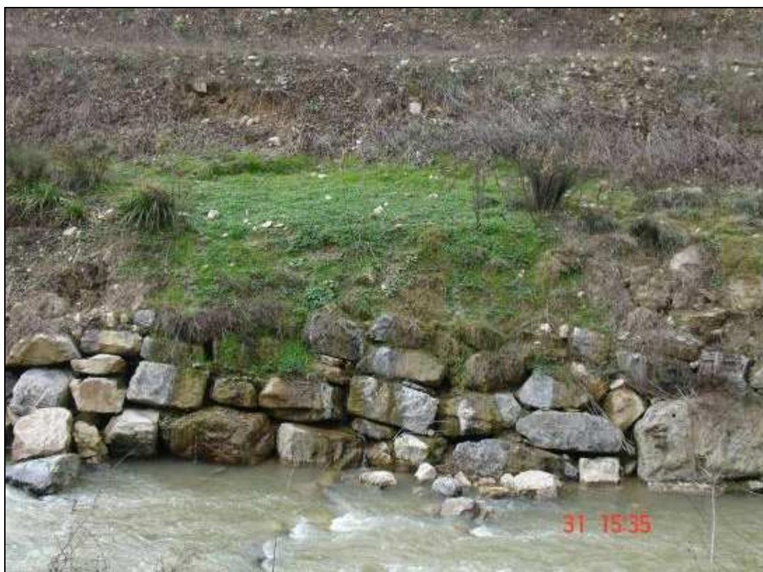
Figura 704: vista della difesa di bassa sponda dalla strada provinciale in destra idraulica. Sono visibili le concentrate venute d'acqua.
