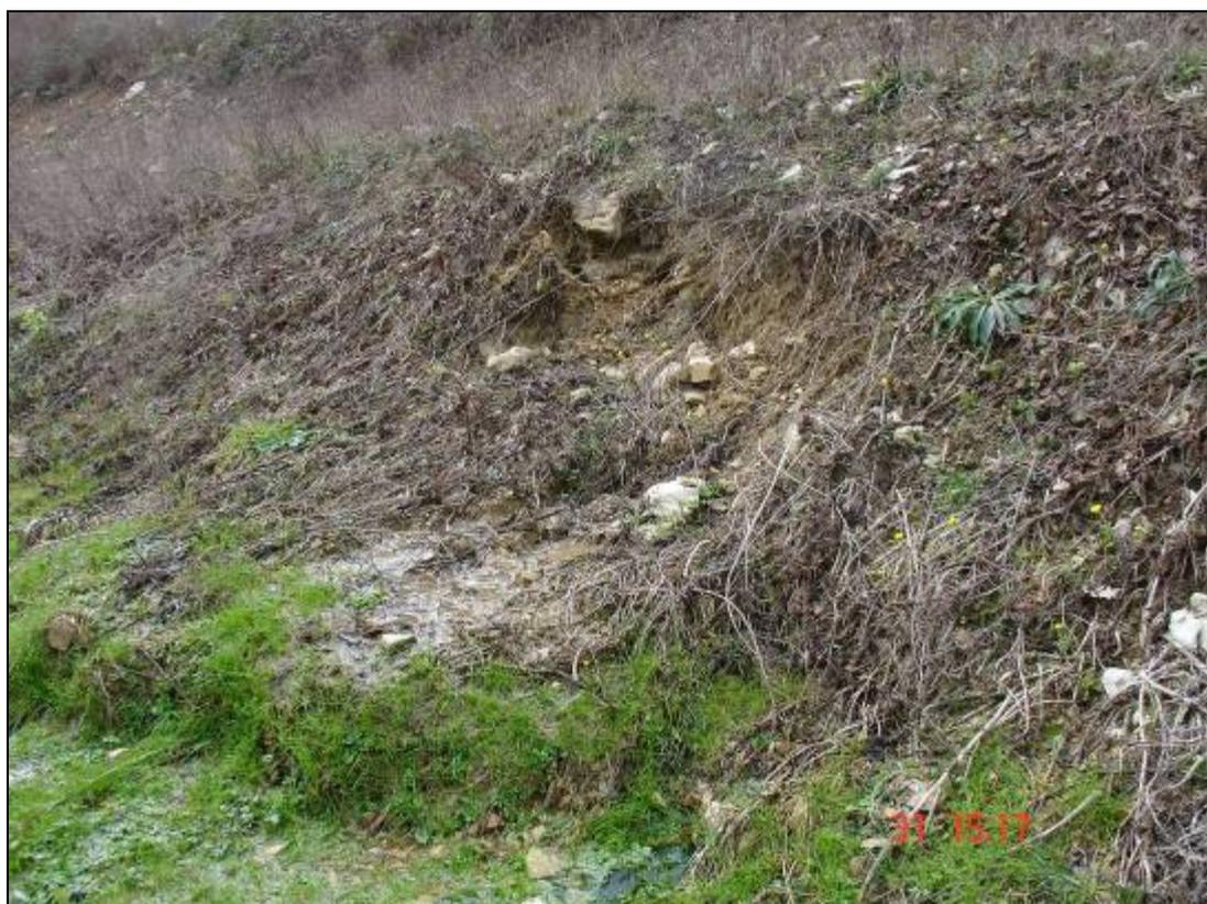
Figura 703: una consistente venuta d'acqua in una delle gradonate presenti al piede del versante.
