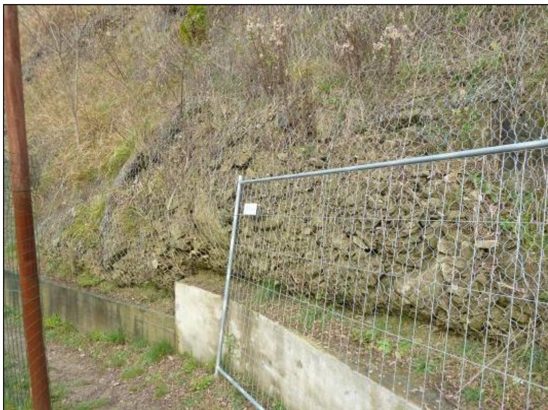
**Figura 711: particolare di una delle reti paramassi in prossimità dell'ingresso alle tribune.**
