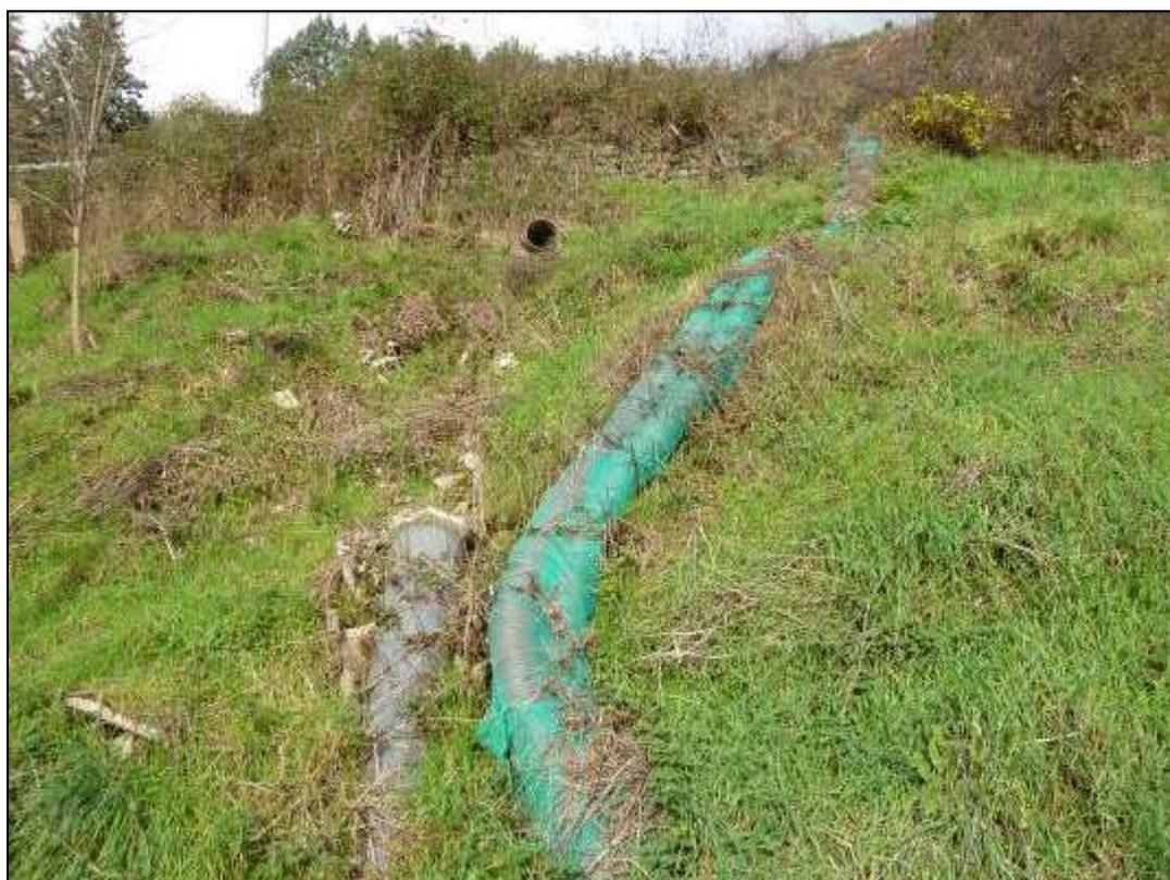
**Figura 710: particolare del tratto di fognatura danneggiato.**
