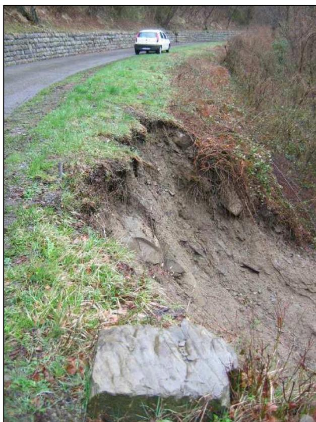
**Figura 557: il coronamento della frana sulla banchina della strada comunale di Casetta di Tiara.**
