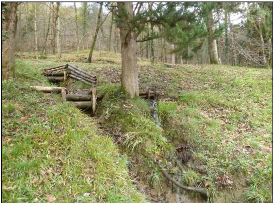
**Figura 737: particolare dello sbocco a valle di un probabile dreno sub orizzontale.**
