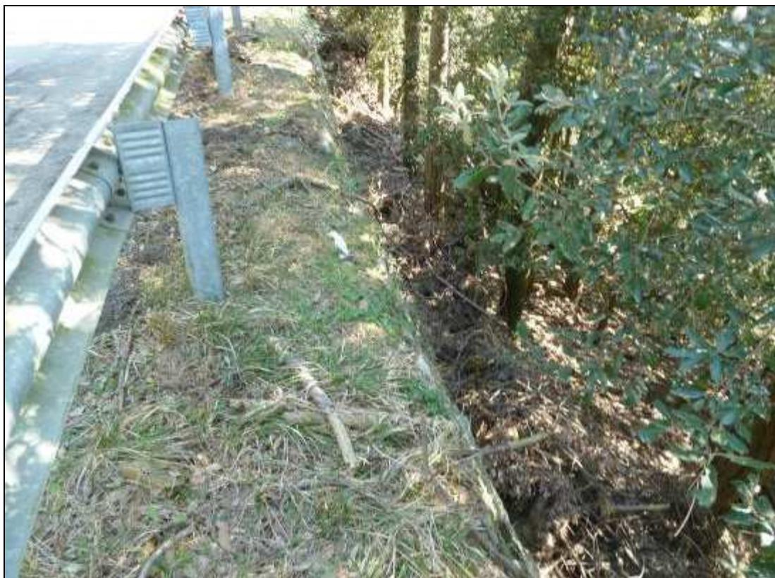
Figura 765: il materiale di risulta di un taglio ammassato a ridosso del muro di contenimento, di valle, della strada.
