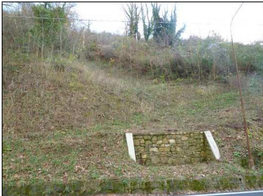
**Figura 729: tratto di muro (con dreni) e sistemazione del versante con fascinate.**
