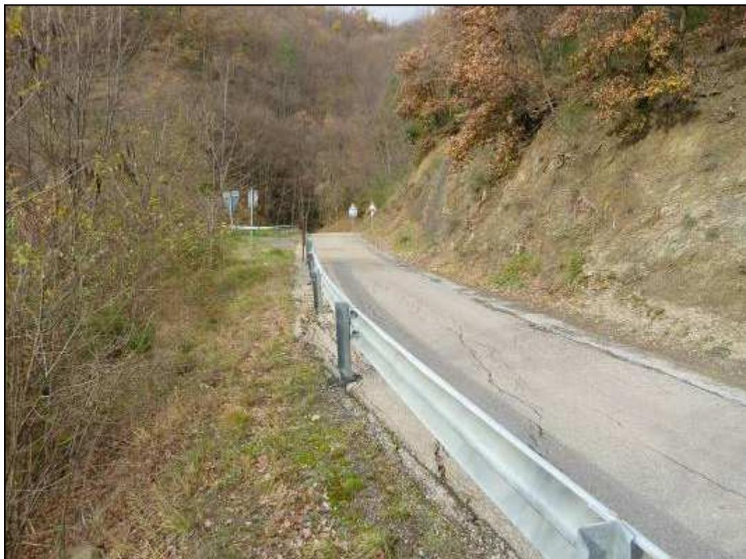
**Figura 724:** il lato valle della strada comunale di Castagneto con il guard rail spostato verso l'interno della carreggiata.
