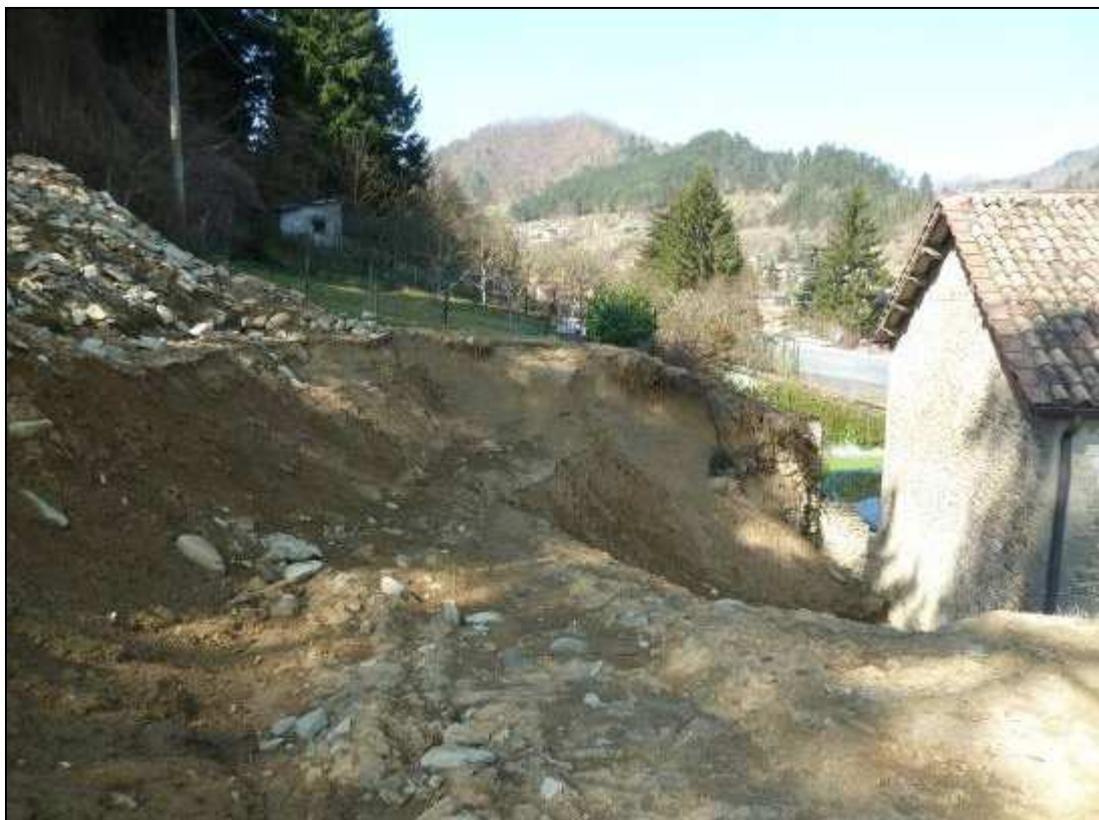
Figura 495: la scarpata a monte della Chiesa. Si noti l'accumulo del pietrame del muro di contenimento crollato.
