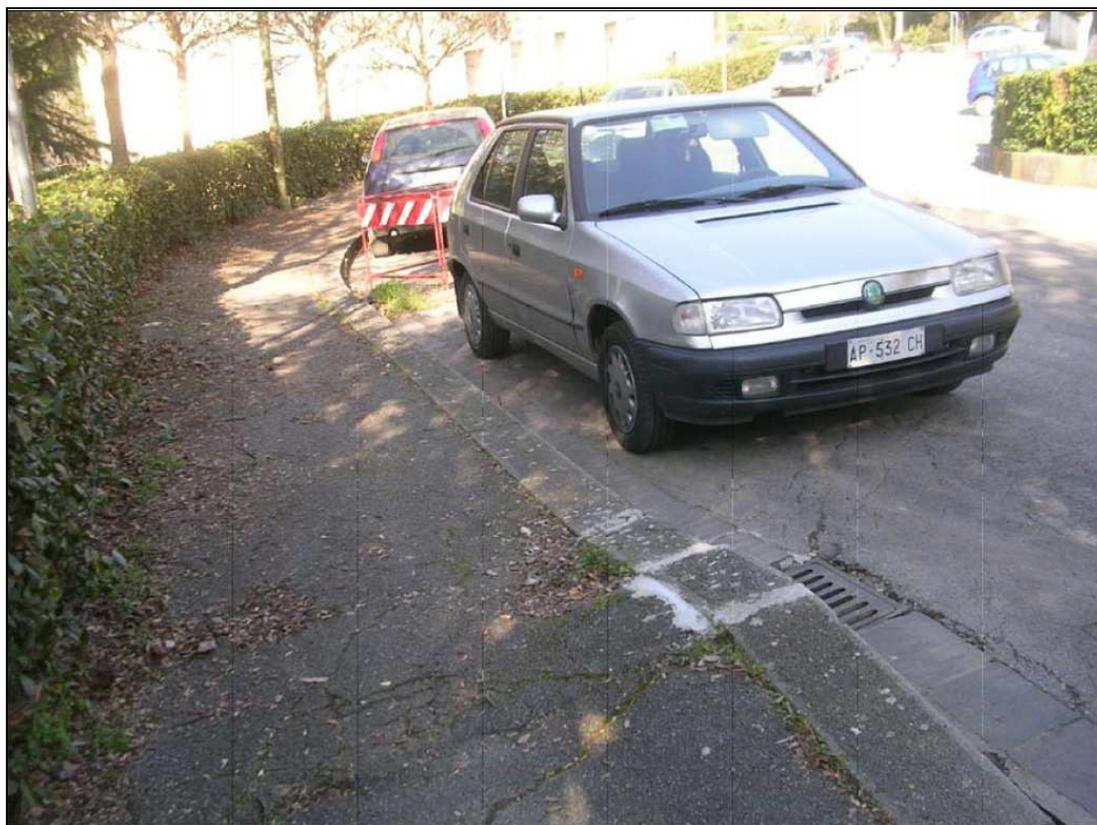
**Figura 358: fenomeni deformativi e rotture dei manufatti stradali lungo via Luigi Longo.**
