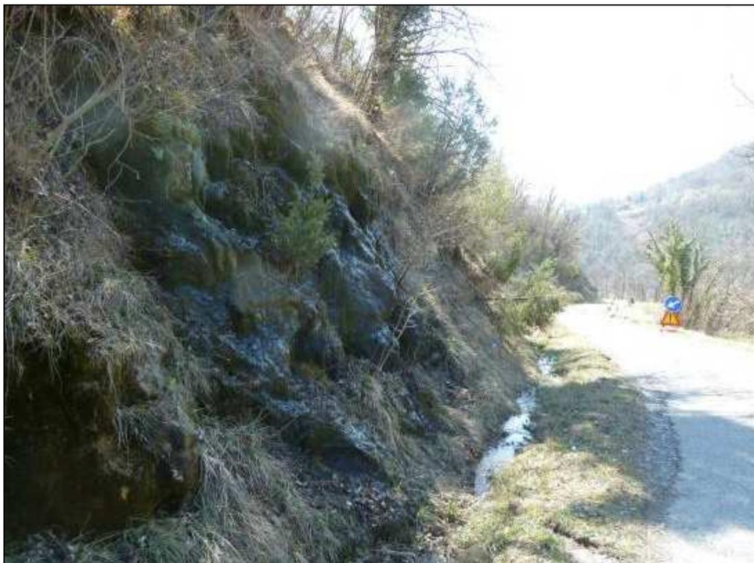
**Figura 508:** la zona sulla scarpata di monte(dove affiora il substrato roccioso) da dove scaturisce una notevole quantità d'acqua.
