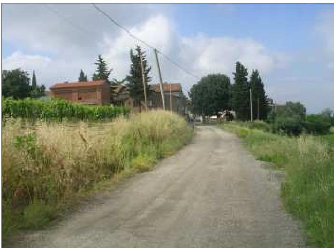
**Figura 450: strada comunale di Coeliaula deformata dal dissesto. Si noti il palo di sostegno della linea elettrica ruotato verso monte.**
