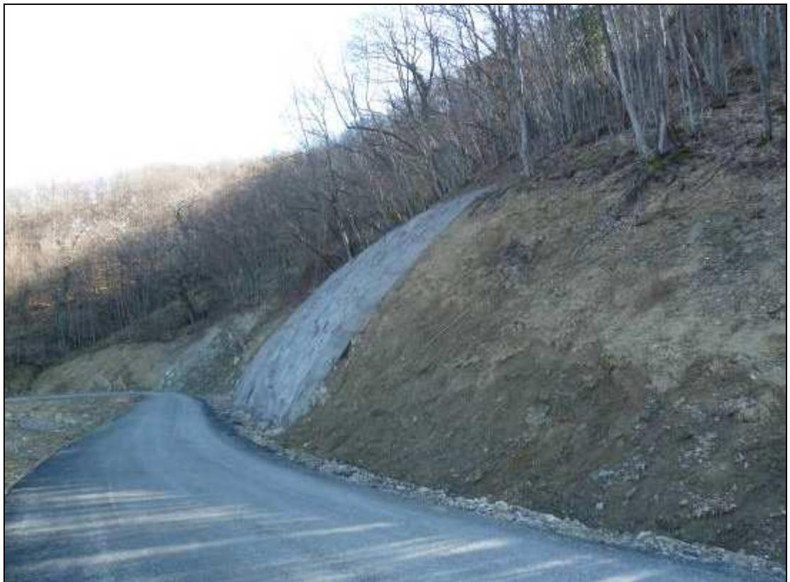
**Figura 480: vista della scarpata di monte con la riprofilatura e la messa in opera della rete paramassi.**
