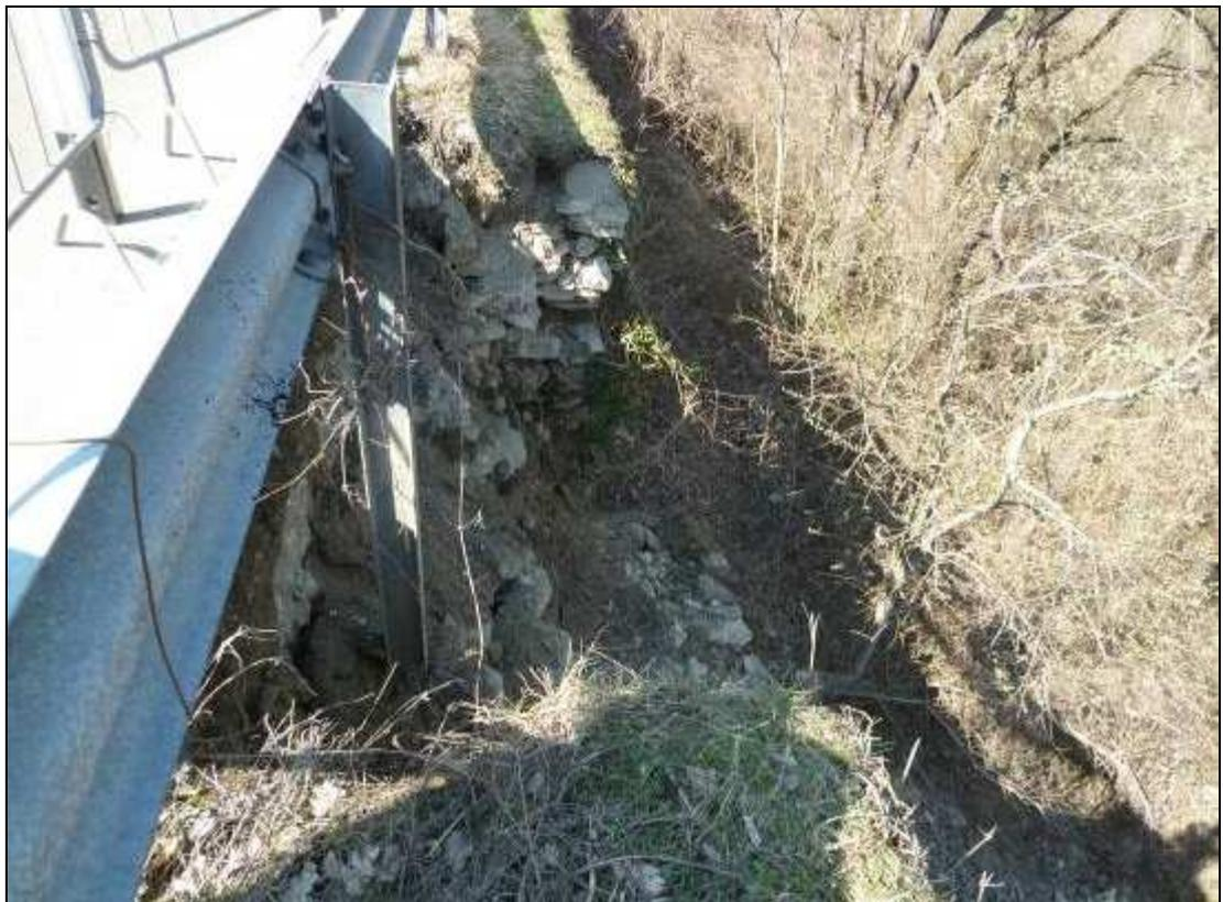
**Figura 521: particolare del crollo del muro di valle.**
