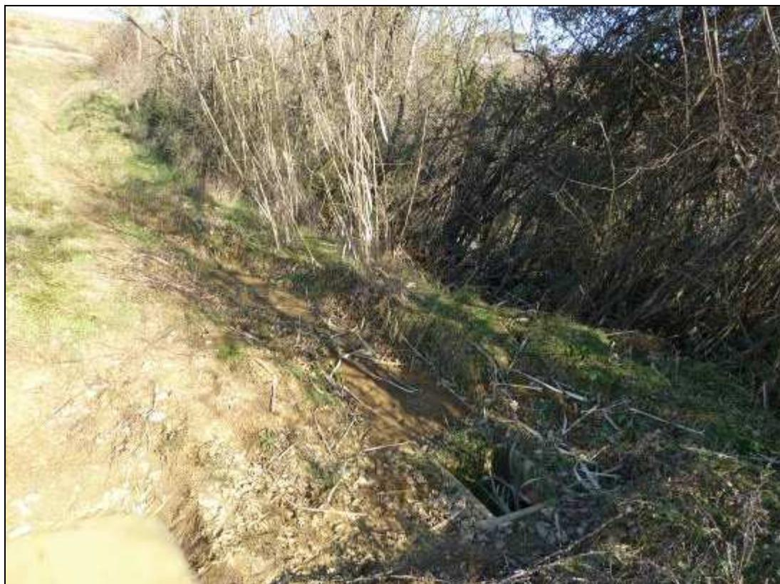
**Figura 364:** la parte terminale di uno dei fossi paralleli e il pozzetto di raccordo con tubazione avente il compito di allontanare le acque raccolte verso il borro sottostante.
