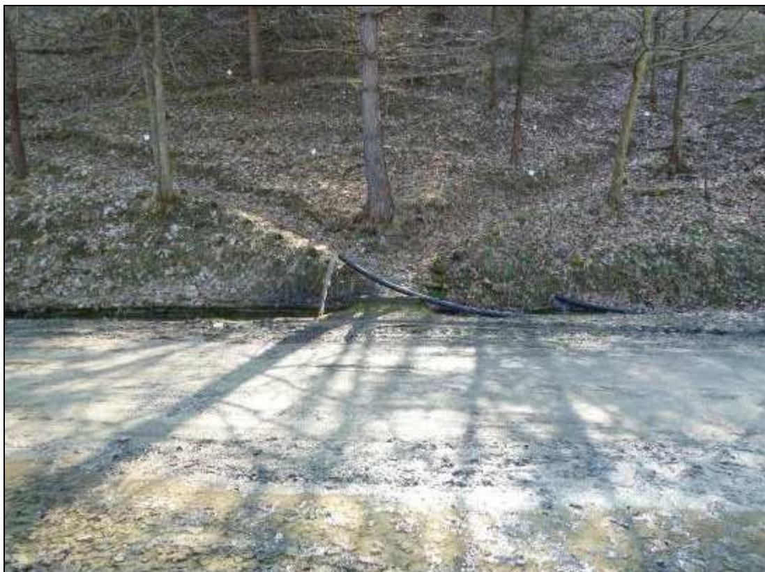
Figura 514: in primo piano il notevole ristagno di acqua causato, nel Parco della Fontana, dagli abbondanti apporti idrici dei tubi di drenaggio.
