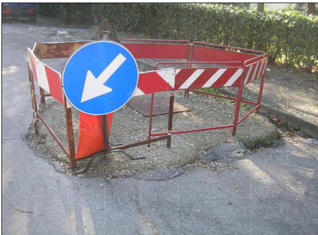
Figura 357: particolare del dissesto con evidente abbassamento del piano stradale rispetto alla soletta di copertura di un pozzo drenante.
