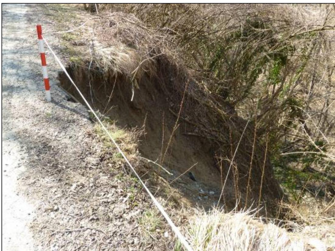
Figura 526: particolare della zona di distacco.
