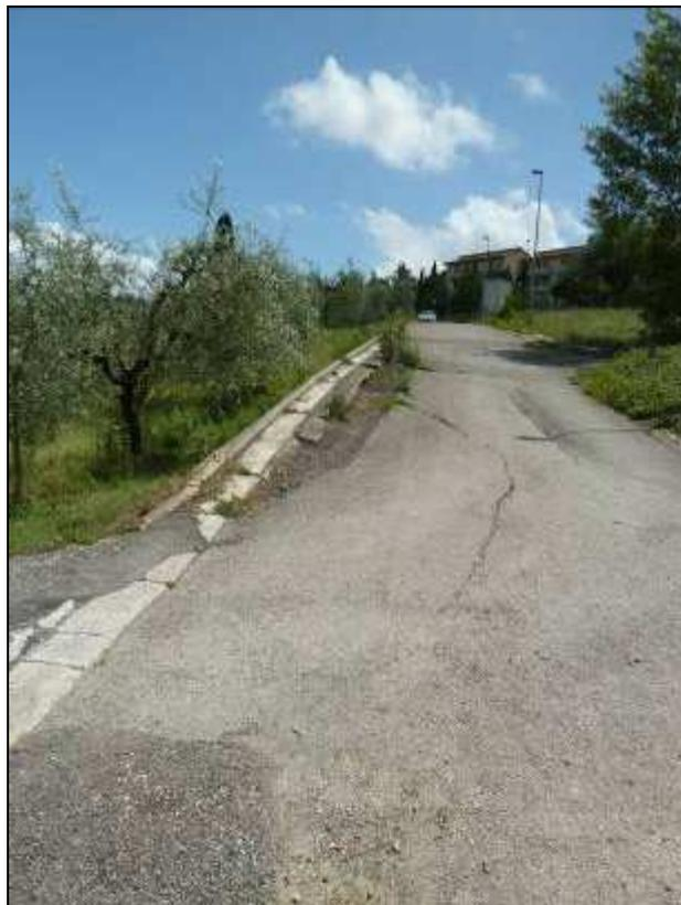
**Figura 461: ancora effetti locali secondari della instabilità dell'area.**
