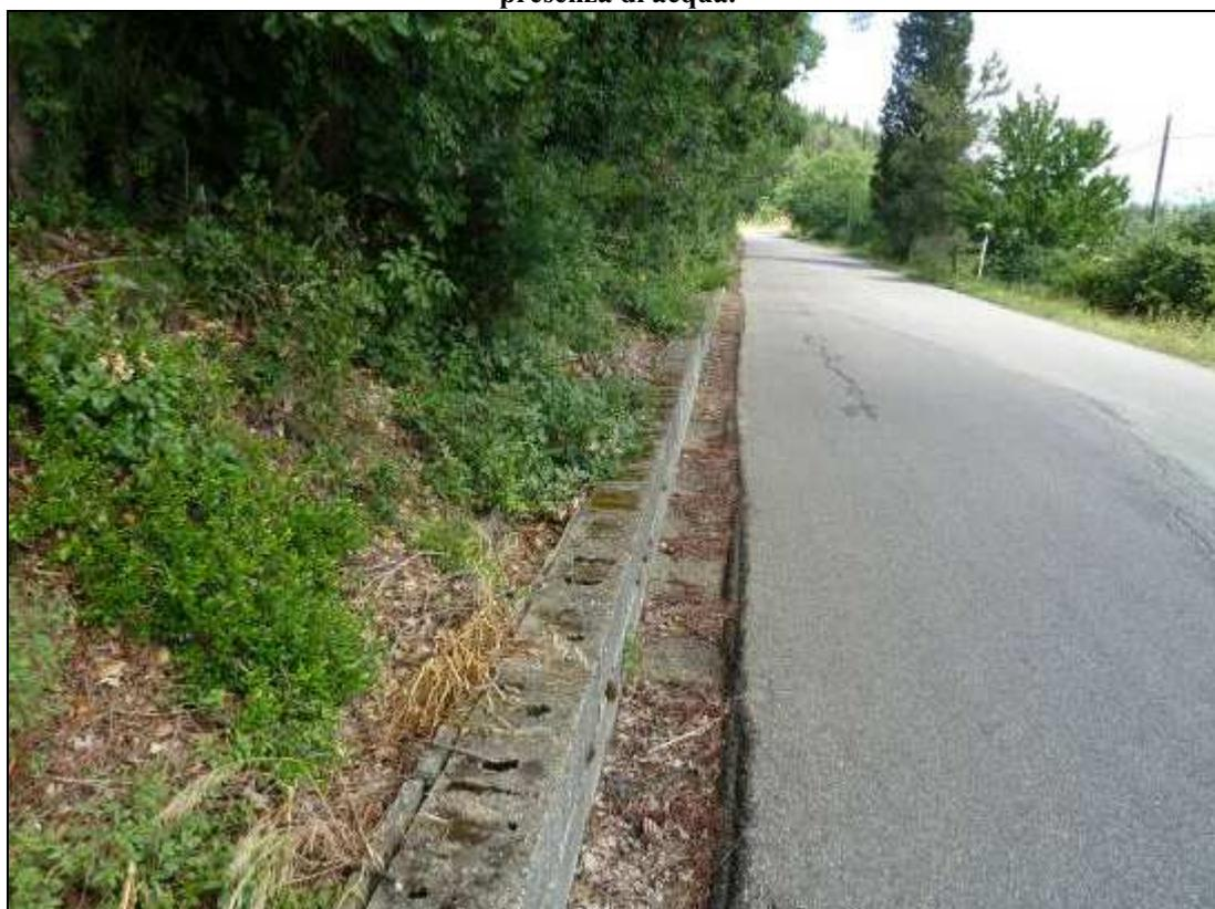
Figura 440: particolare della zanella stradale e della cunetta (posta subito a monte del muretto stradale) realizzata con elementi di calcestruzzo. Si noti lo stato manutentivo.
