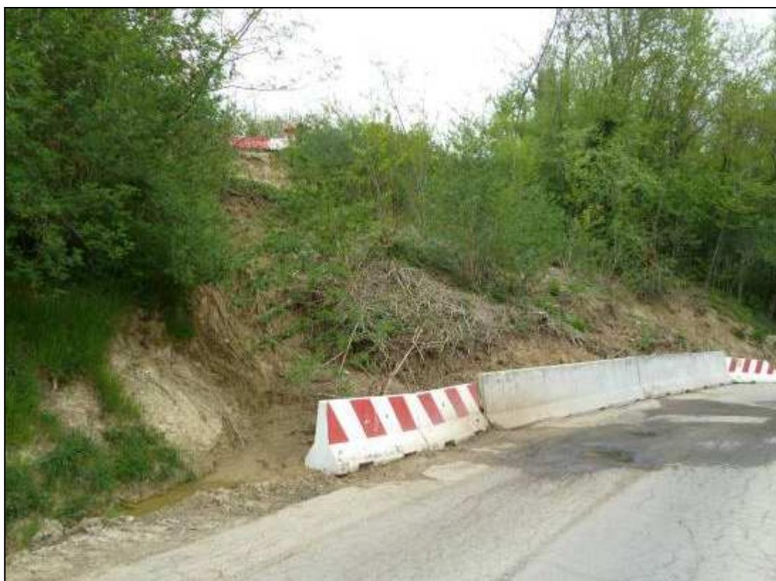
**Figura 392: la zona del piede della frana. Il dissesto, infatti, con il materiale mobilizzato, ha coinvolto un ulteriore tratto della S.P. n. 20.**
