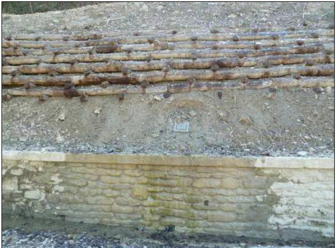
**Figura 515: particolare della palificata con la presenza di abbondante acqua.**
