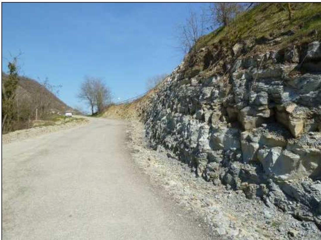
**Figura 475: il lavoro di rettifica e di spostamento verso monte del tracciato della strada andando ad interessare il substrato roccioso.**
