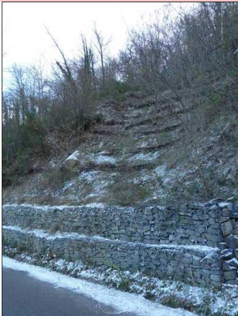
**Figura 370: la gabbionata di base e la sistemazione del pendio.**
