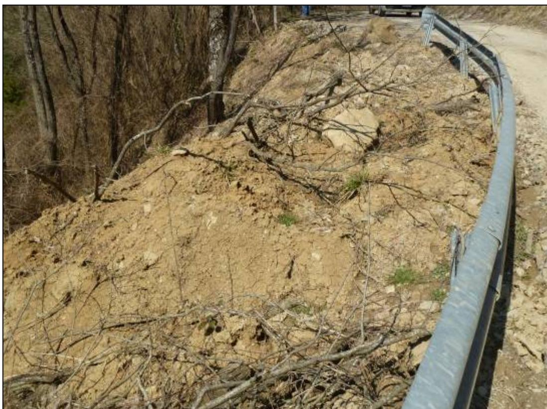
Figura 533: il materiale accumulato sul lato valle della strada.
