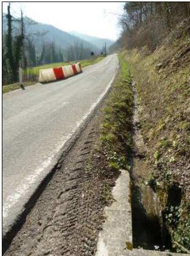
Figura 409: l'abbondante acqua proveniente dal versante a monte della viabilità provinciale.
