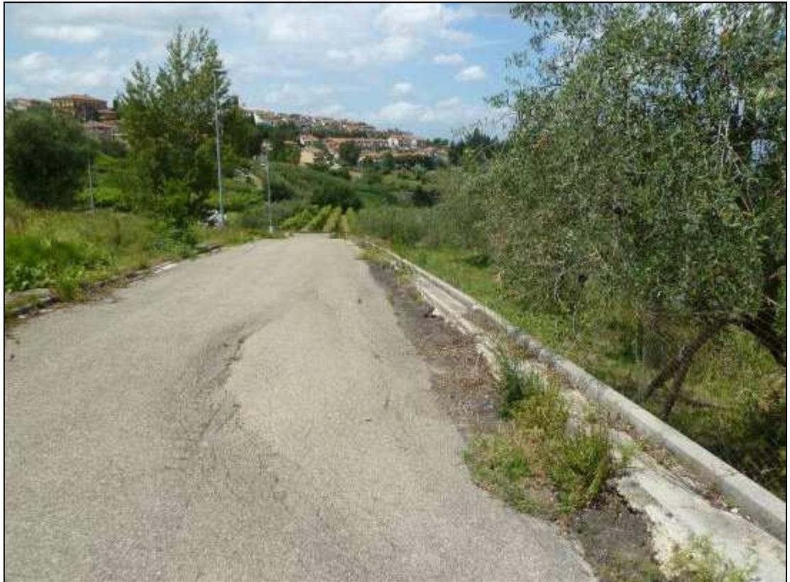
**Figura 460: alcuni effetti locali secondari, della instabilità dell'area, a carico di una strada.**
