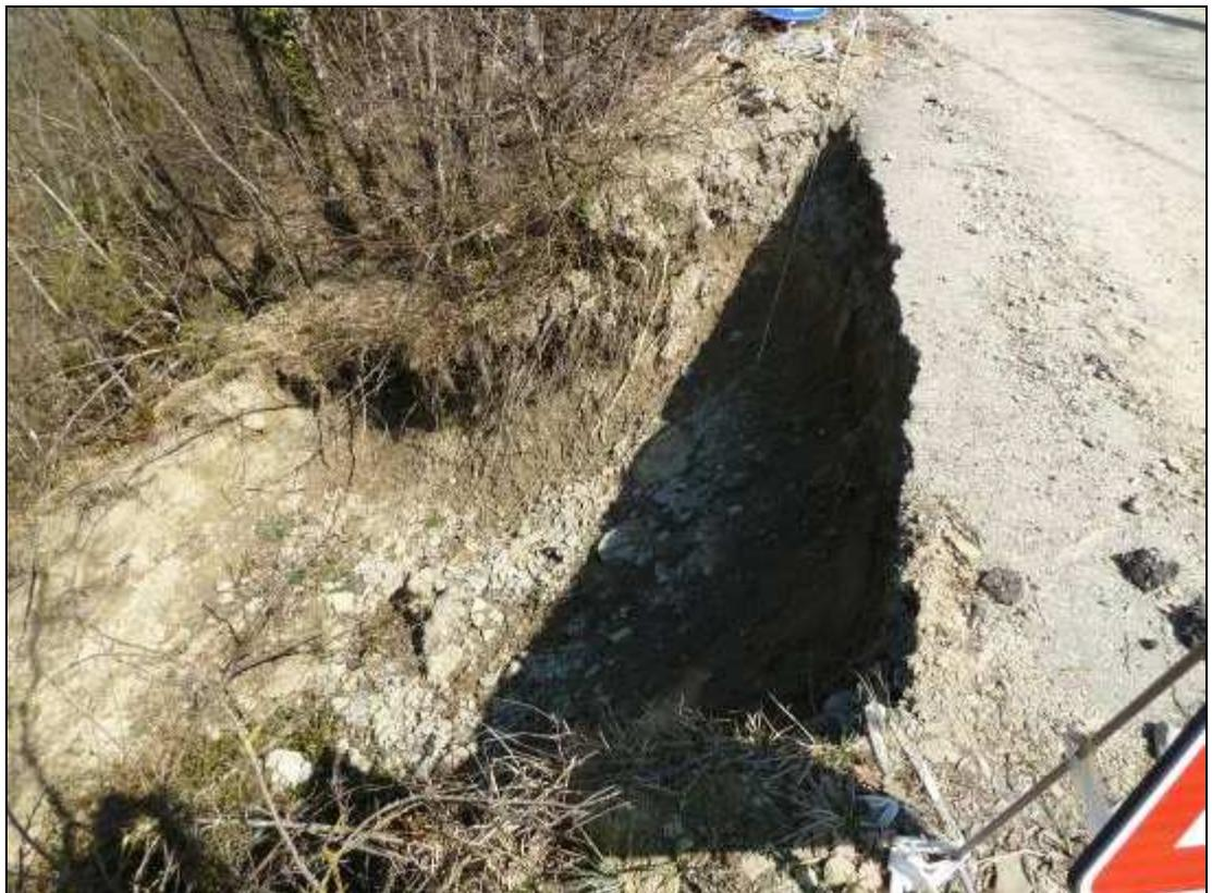
Figura 539: particolare della nicchia di distacco.
