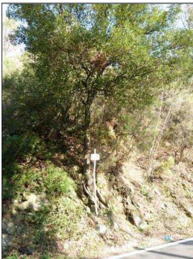
**Figura 347:** leccio presente sulla scarpata di monte della strada provinciale. Si noti l'apparato radicale estremamente superficiale.
