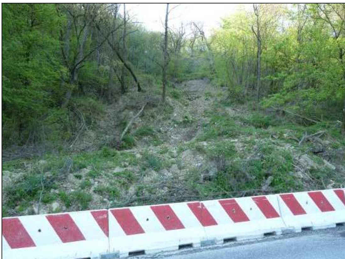
Figura 291: foto frontale del corpo di frana. I materiali mobilizzati hanno coinvolto anche la sede stradale (adesso protetta da una barriera di elementi new jersey).
