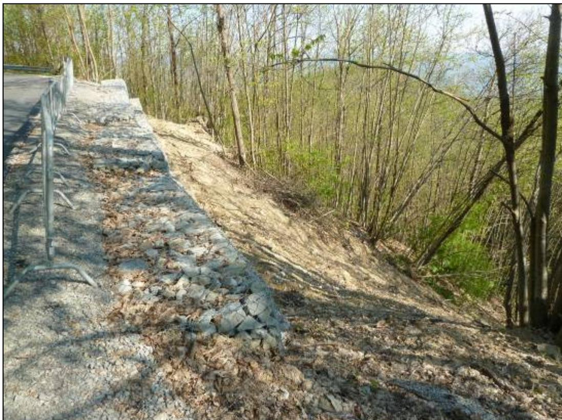
**Figura 305: il consolidamento della viabilità comunale mediante l'utilizzo della gabbionata.**
