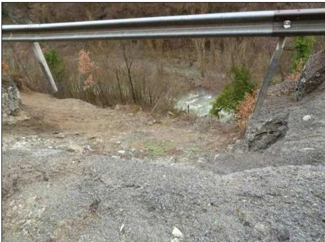
Figura 252: la frana (febbraio 2011) con la parte più avanzata ha raggiunto il fiume Santerno (in secondo piano nella foto).
