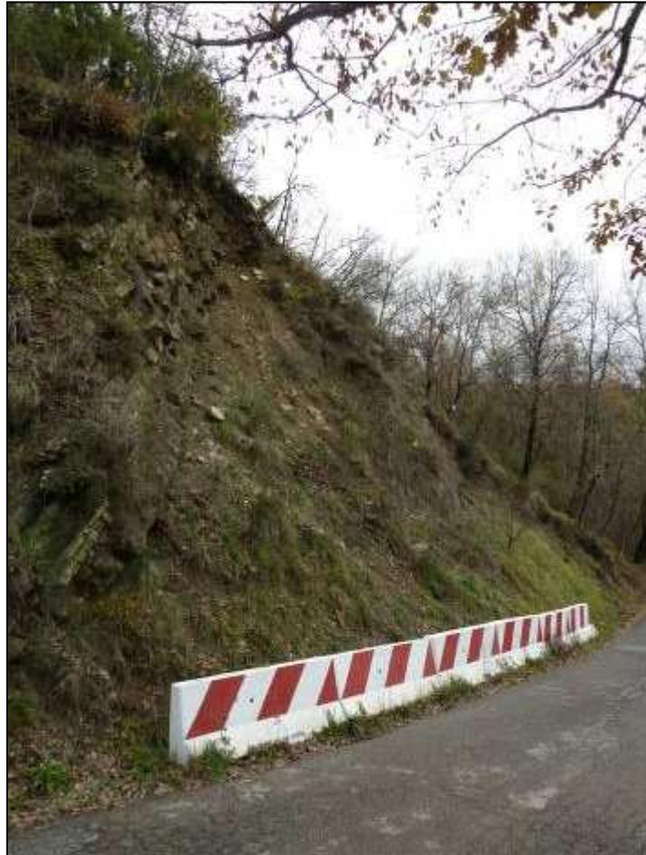
**Figura 81: barriera new jersey posta alla base della zona instabile.**
