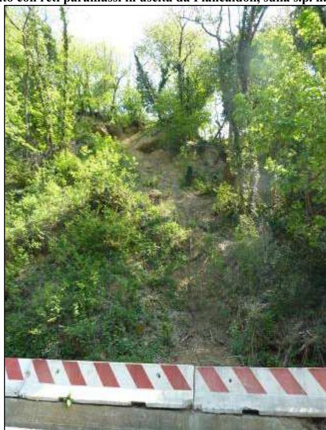
Figura 205: frana sulla scarpata di monte della s.p. n. 58 tra Piancaldoli e la località Il Poggio.
