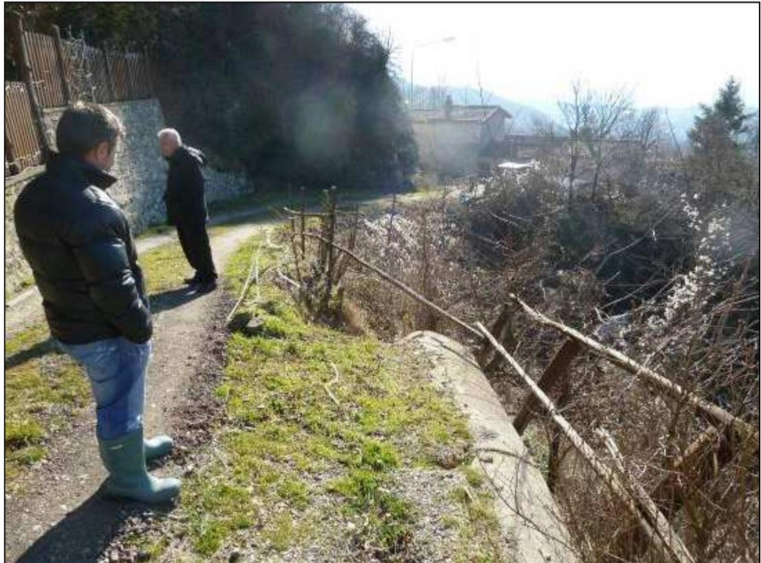
**Figura 246: il muro di sostegno, a valle della strada. Si noti l'inclinazione.**
