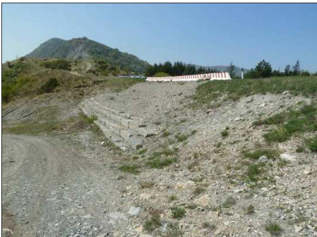
**Figura 181: la scarpata di valle della strada. Si noti la sistemazione con blocchi di pietra.**
