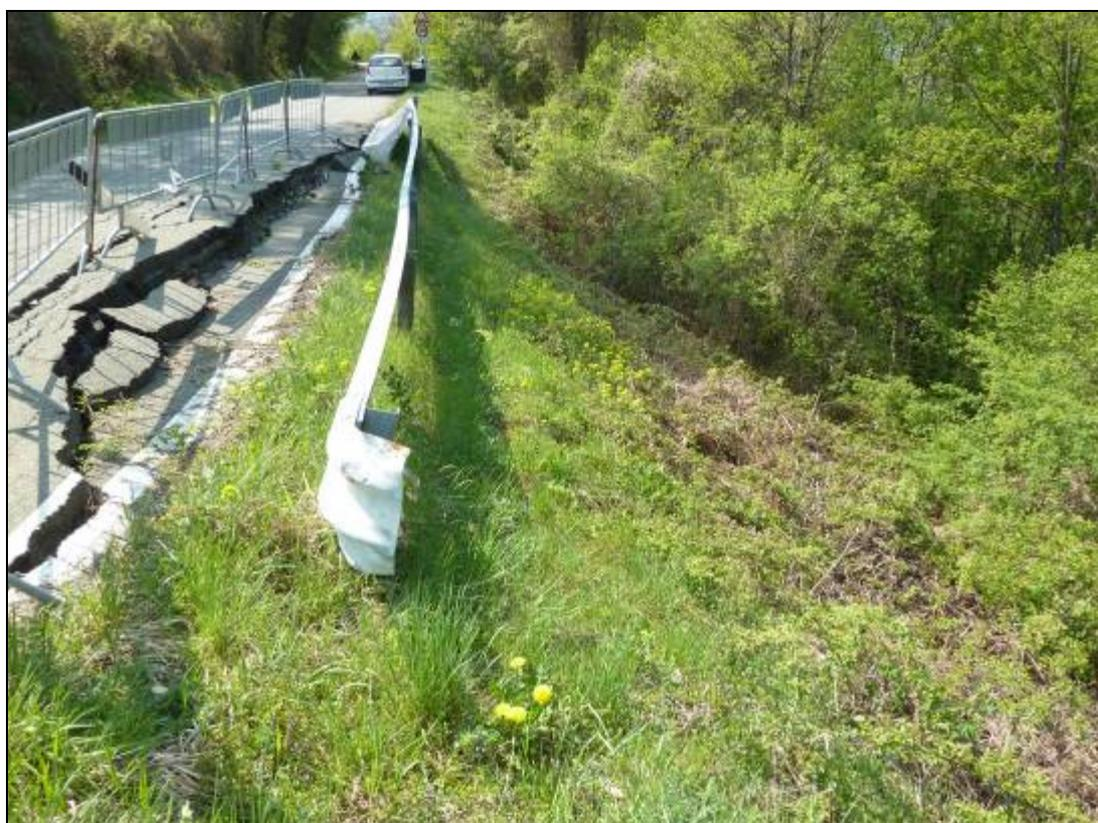
Figura 231: particolare del coronamento della frana con il notevole abbassamento del paiano viario.
