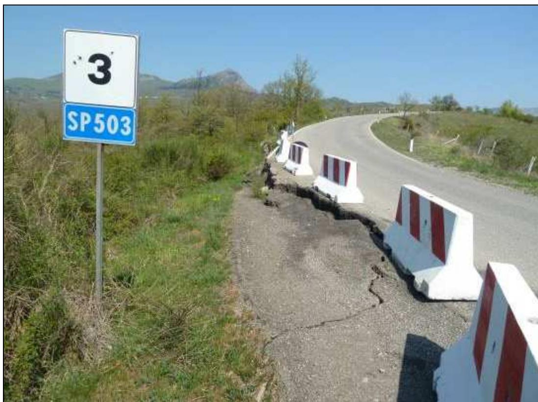
Figura 277: l'abbassamento del piano stradale in corrispondenza del coronamento della frana al km 3 della s.p. n. 503.
