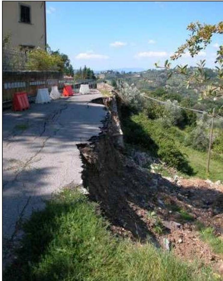
**Figura 32: il dissesto con la porzione del muro di sostegno e della viabilità coinvolte.**
