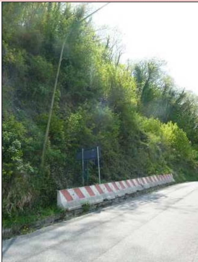
Figura 204: pendio sistemato con reti paramassi in uscita da Piancaldoli, sulla s.p. n. 58, in direzione Firenzuola.
