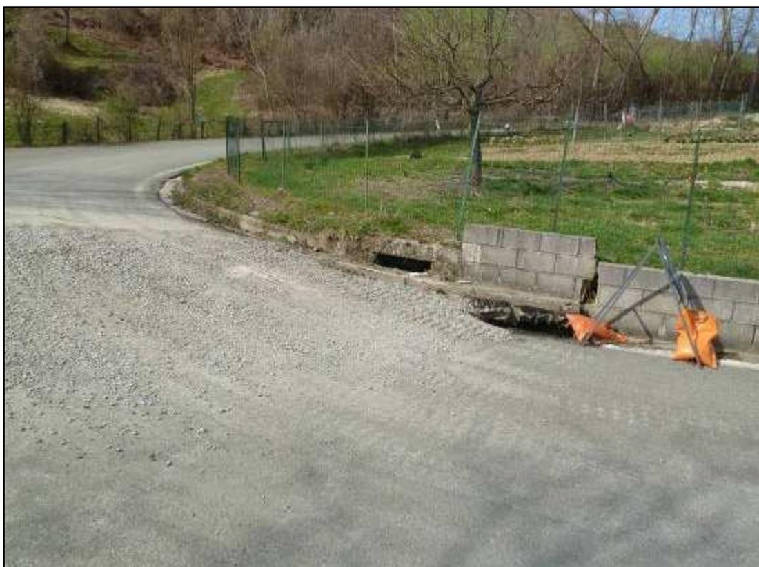
Figura 219: l'evidente abbassamento del piano stradale evidenziato anche dalla rottura del muretto stradale.
