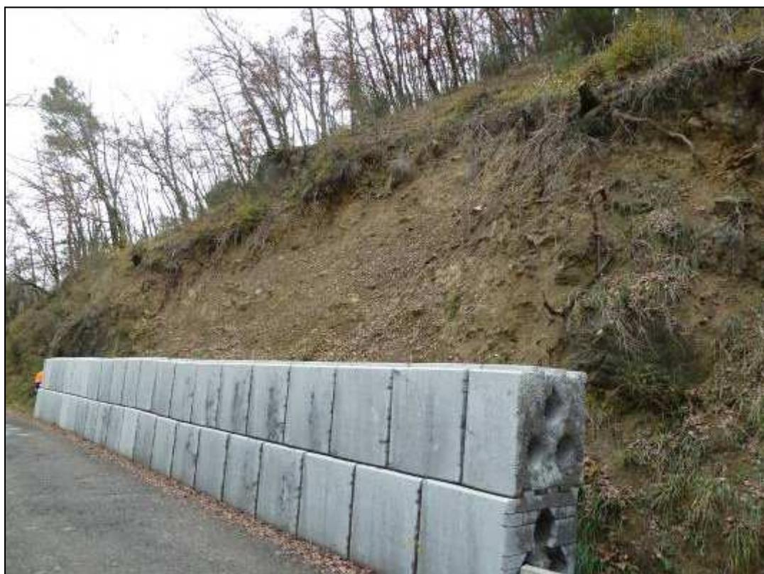
Figura 88: l'area in frana con il doppio ordine di barriere new jersey poste a protezione della sede stradale.
