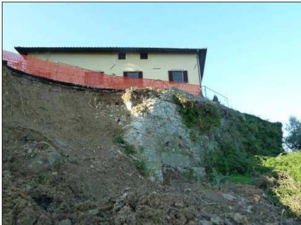
**Figura 33: il crollo del muro stradale visto dal basso.**
