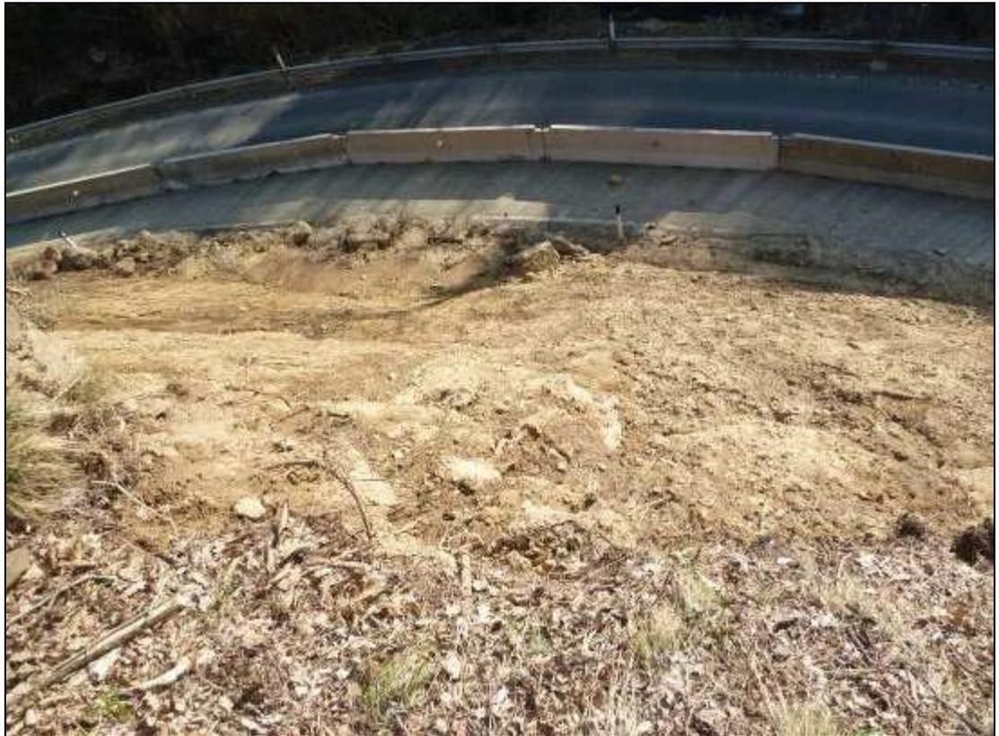
Figura 60: ripresa fatta sul versante in frana da monte verso la strada. Si noti l'elevata pendenza del pendio.
