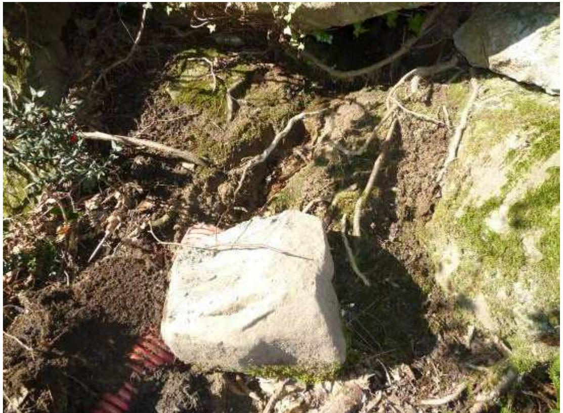
Figura 61: una delle sorgenti presenti nell'area del dissesto le cui acque sono state captate e allontanate.
