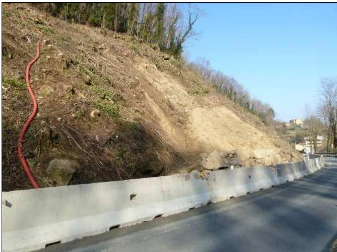
**Figura 59:** l'area di cantiere. Si può notare la barriera new jersey, la scogliera ed un tubo corrugato per drenare e allontanare l'acqua dalla pendice.
