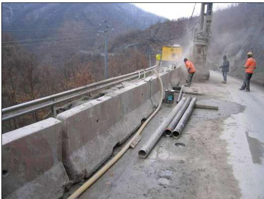
Figura 254: ancora una fase dei lavori di realizzazione della paratia di micropali. (febbraio-marzo 2010).
