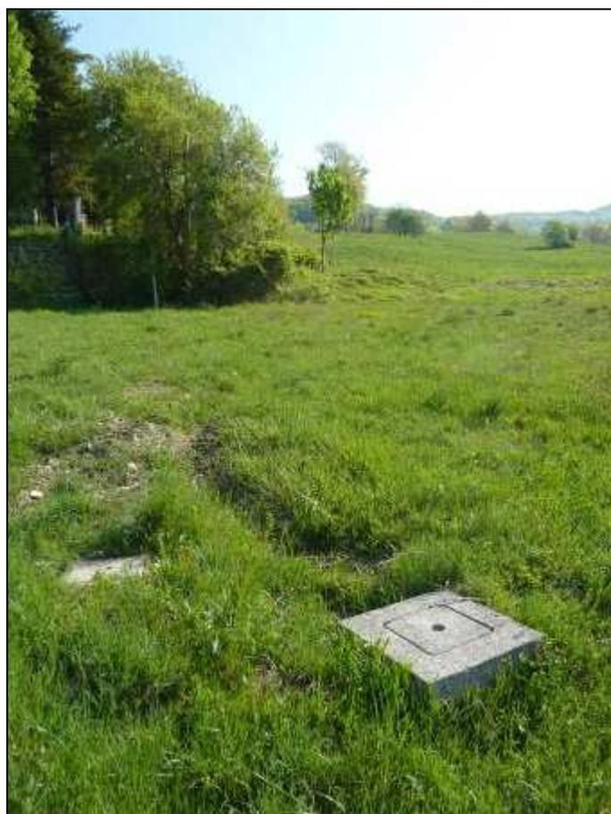
**Figura 138: pozzetti e fossetti per l'intercettazione e la regimazione delle acque superficiali.**
