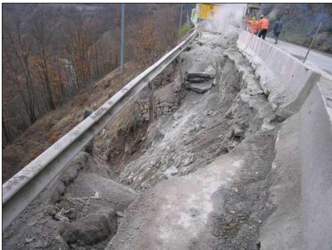
Figura 253: la realizzazione della paratia di micropali per consentire la riapertura, ad una carreggiata, della viabilità (febbraio-marzo 2010).
