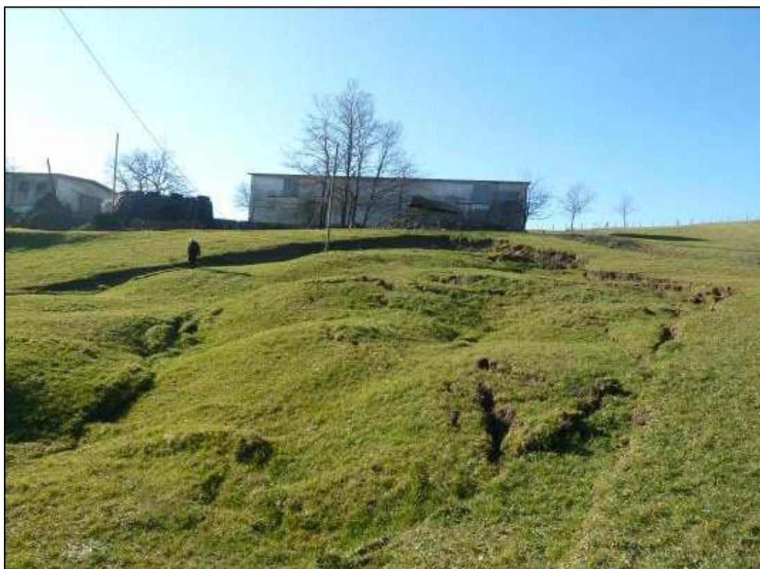
**Figura 237: vista della zona del coronamento e della nicchia di distacco.**
