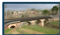
Adeguamento Ponte SP64 Km 7+700
