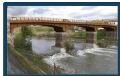
Adeguamento Ponte sulla SP106
