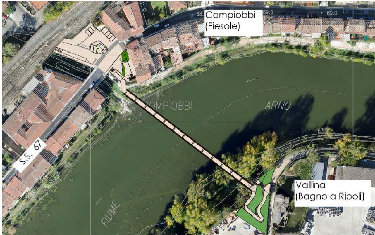
Vista dall'alto del ponte
