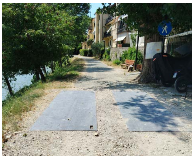
Posizionamento lastra di acciaio per viabilità di cantiere
