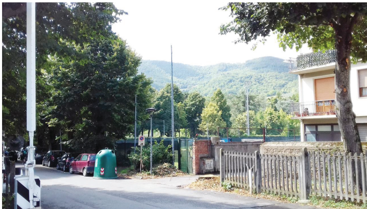
Foto 5: l'impianto dal lato nord-est in corrispondenza dell'intersezione tra la sede ferroviaria ed il Viale Giuseppe Mazzini
