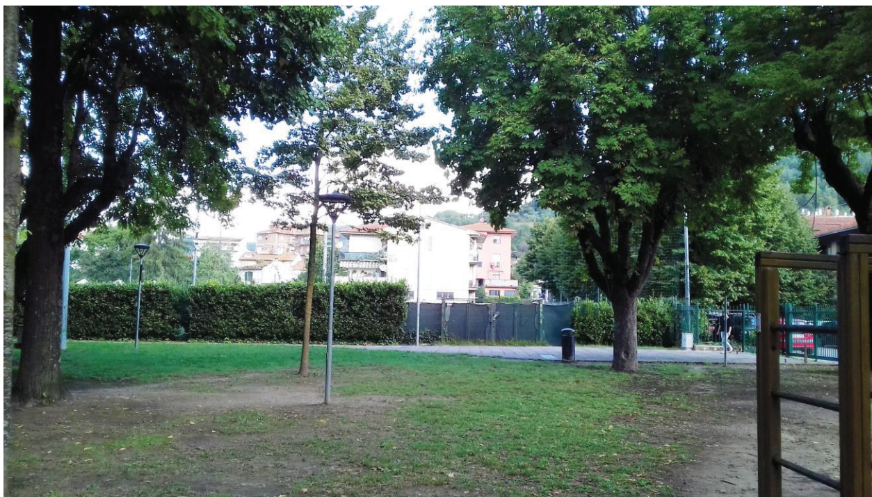
Foto 7: l'impianto vista dal lato sud dall'interno del parco dell'Albereta
