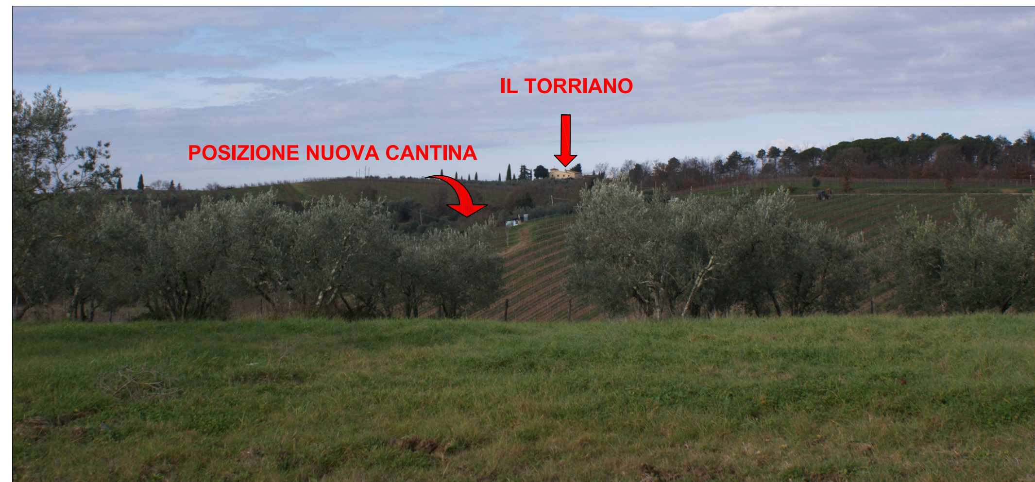
FOTO PANORAMICA DA VIA DELL'OLMO
