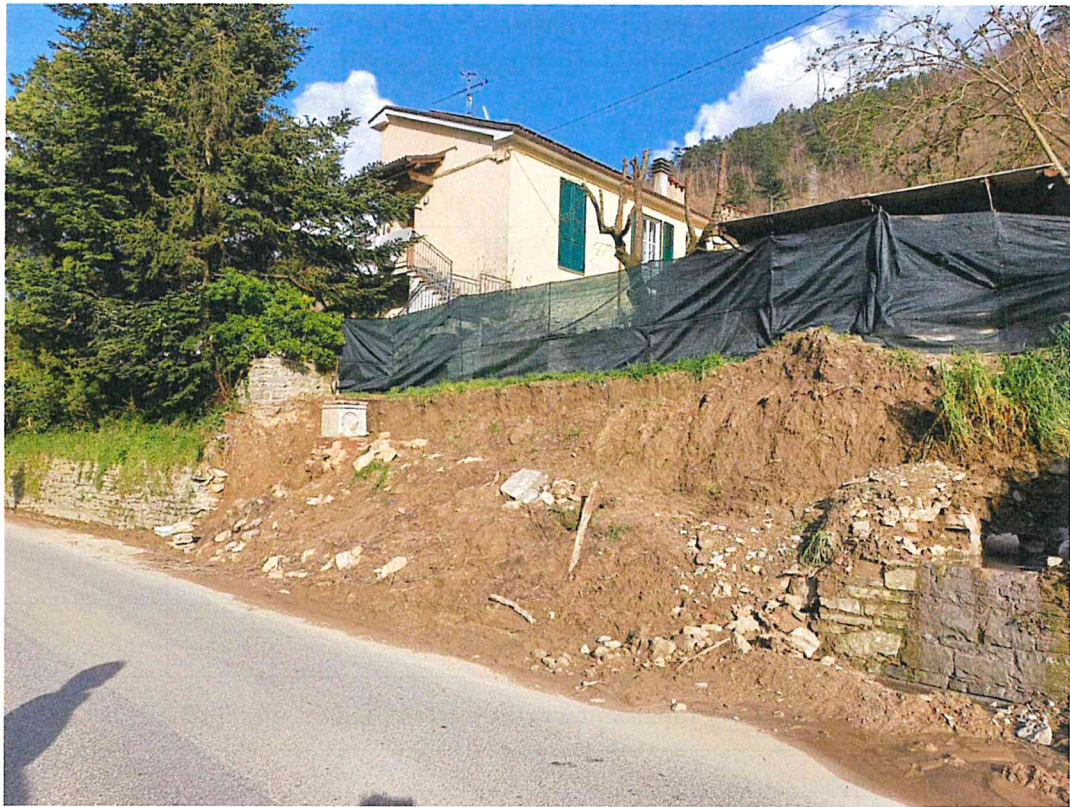
Foto 1: SR 302 km 62+700 Muro di sostegno scarpata franato
