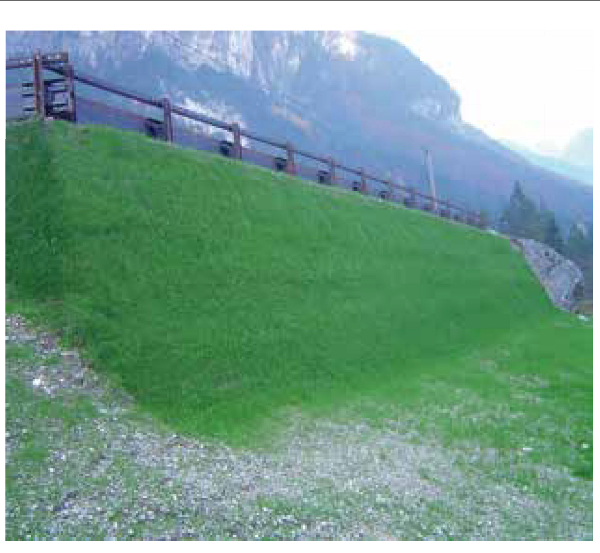
RILEVATO PER PIAZZALE CON SISTEMA DELLE TERRE RINFORZATE E PARETI INERBITE
