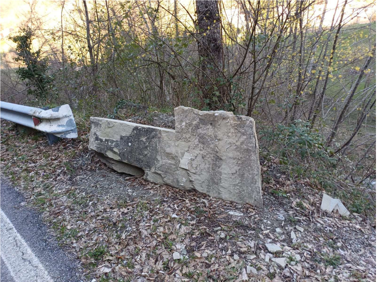
Foto 2: Sp 74 Caduta massi in strada
