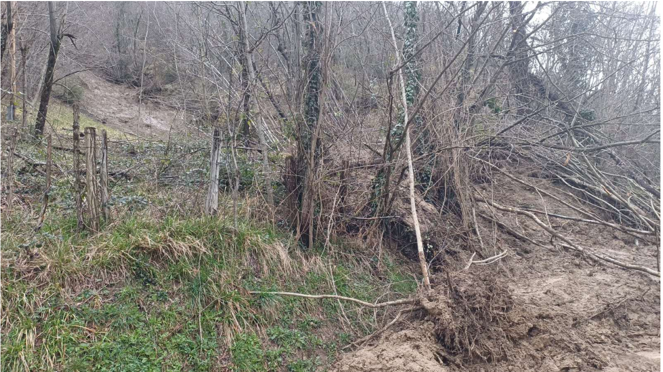
Figura 4 SP 74 Km 4+400 frana di monte
