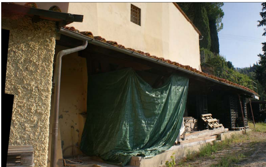
Prospetto Sud-Ovest - particolare tettoia a sbalzo
