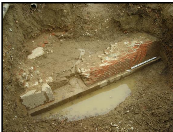
Figura 11. La struttura in mattoni e bozze di arenaria del bastione della Serpe
