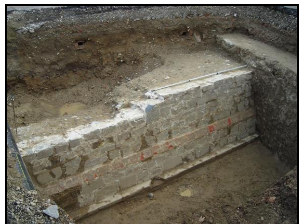
Figura 11. La struttura in mattoni e bozze di arenaria del bastione della Serpe
