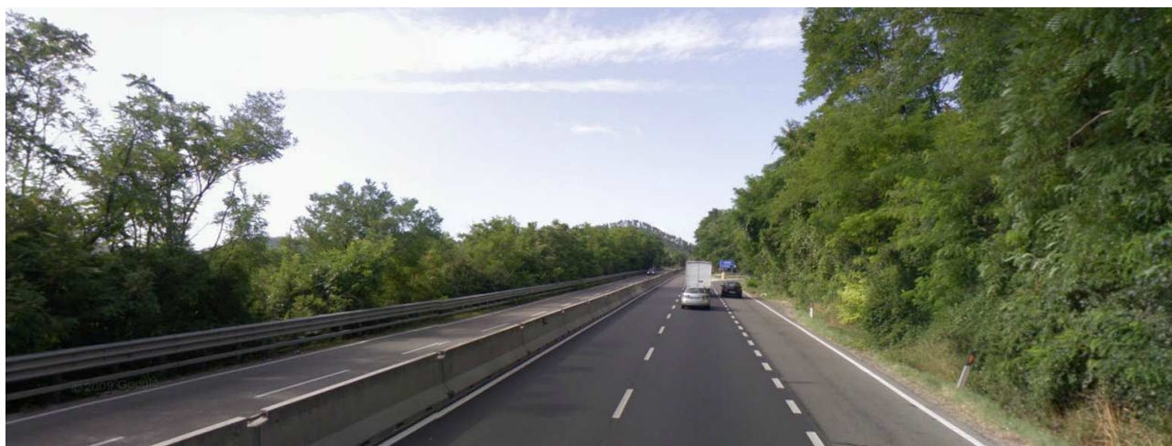
Figura 36 - Foto della carreggiate esistete sul raccordo autostradale Firenze-Siena
