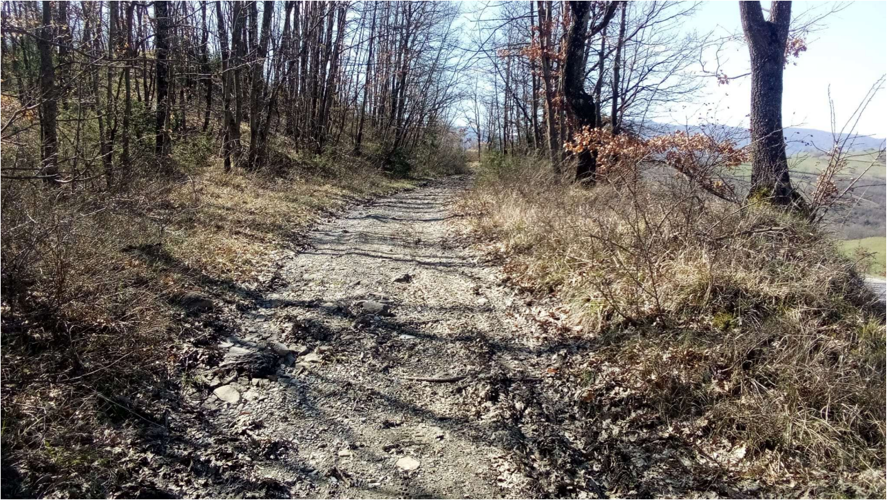
Fig 9 –Vista a monte della frana al km 4+900
