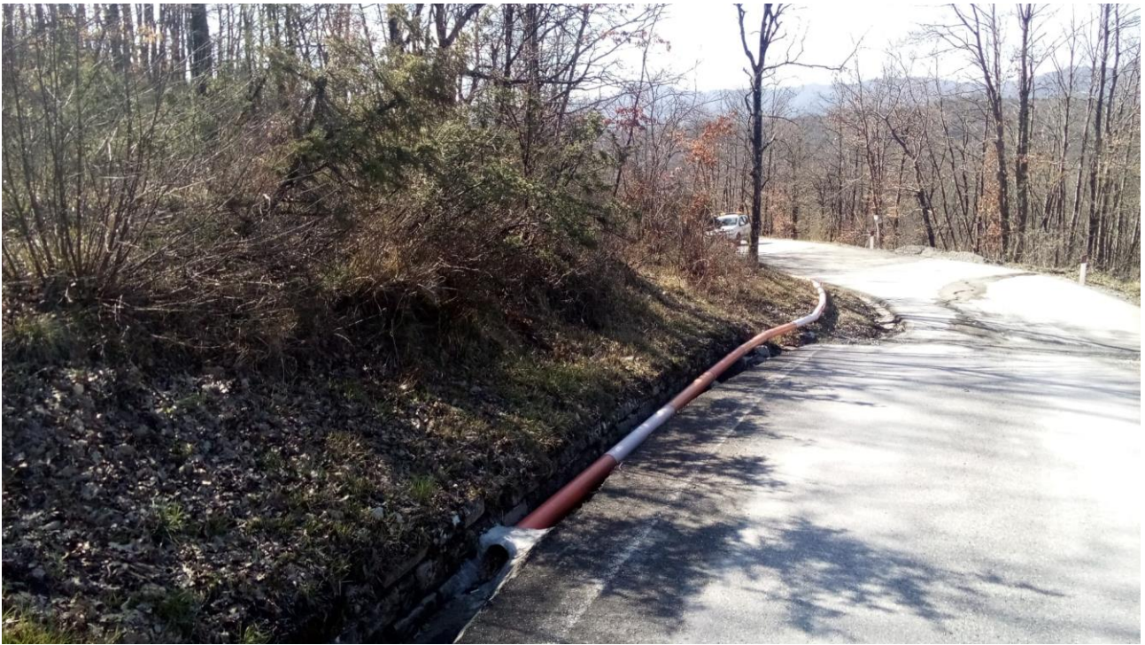
Foto 2: SP117 area boscata oggetto di pulizia e disbosco
