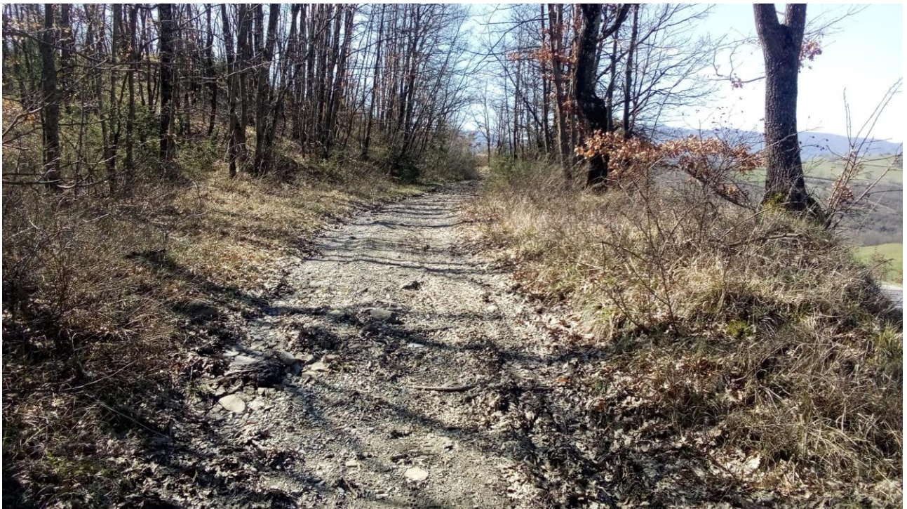
Foto 2: SP117 area boscata oggetto di pulizia e disbosco
