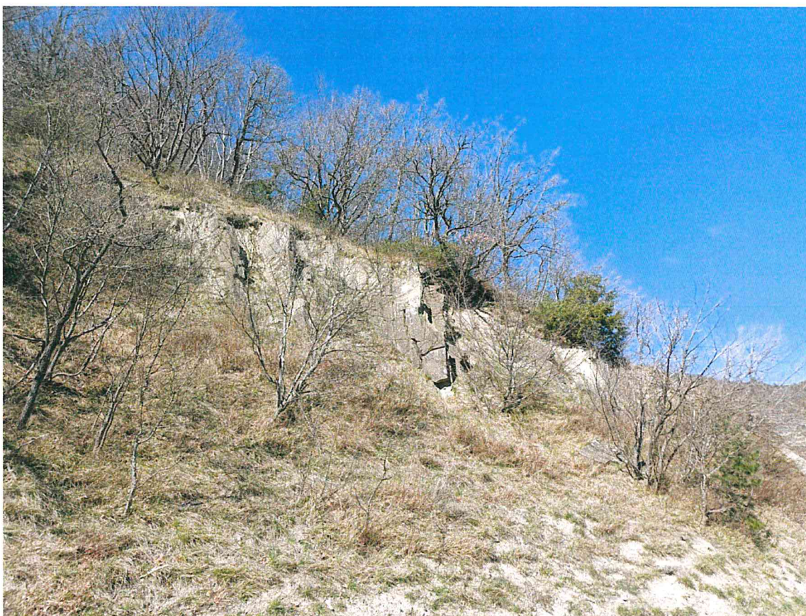
Foto 4: SP 306 massi ciclopici instabili ed in distacco presenti in scarpata
