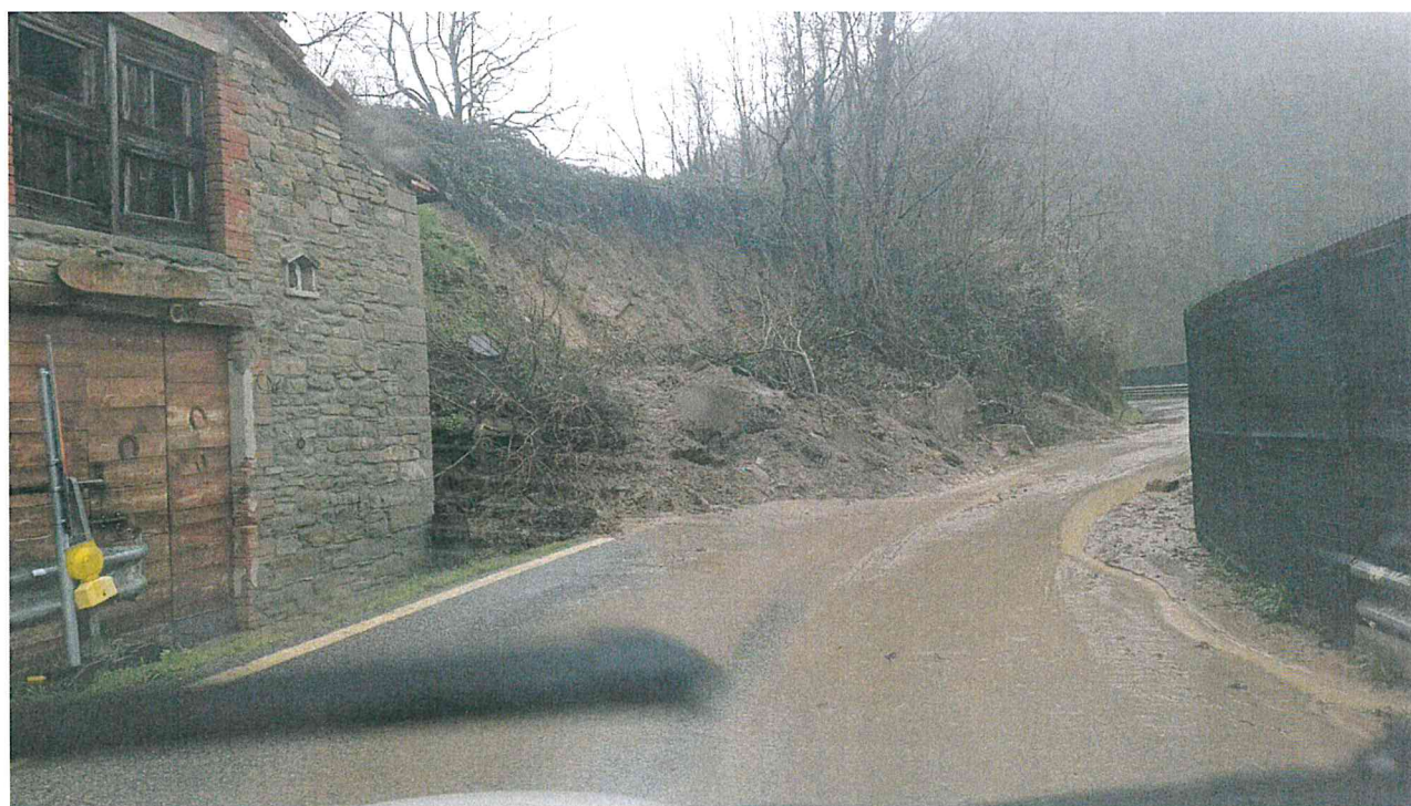
Foto 3: SR 302 frana di monte con presenza di materiale in strada
