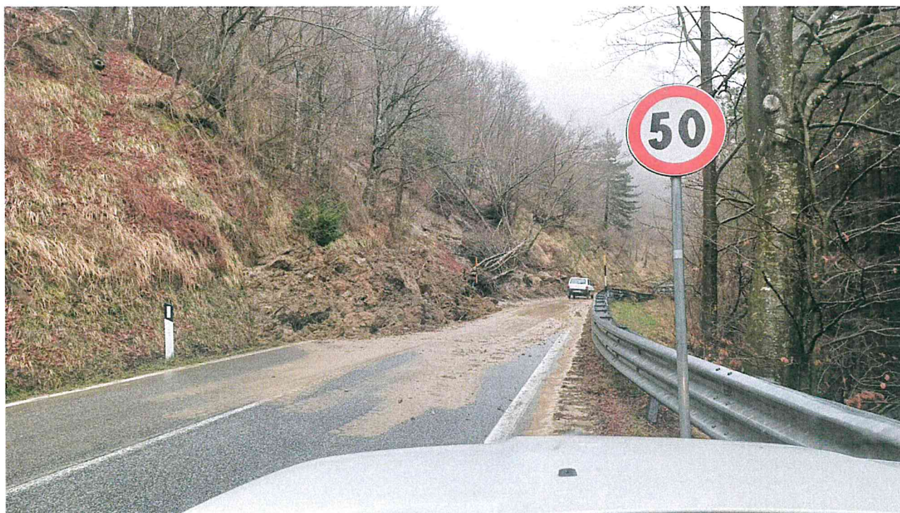
Foto 3: SR 302 km 45+800 frana di monte con presenza di materiale in strada
