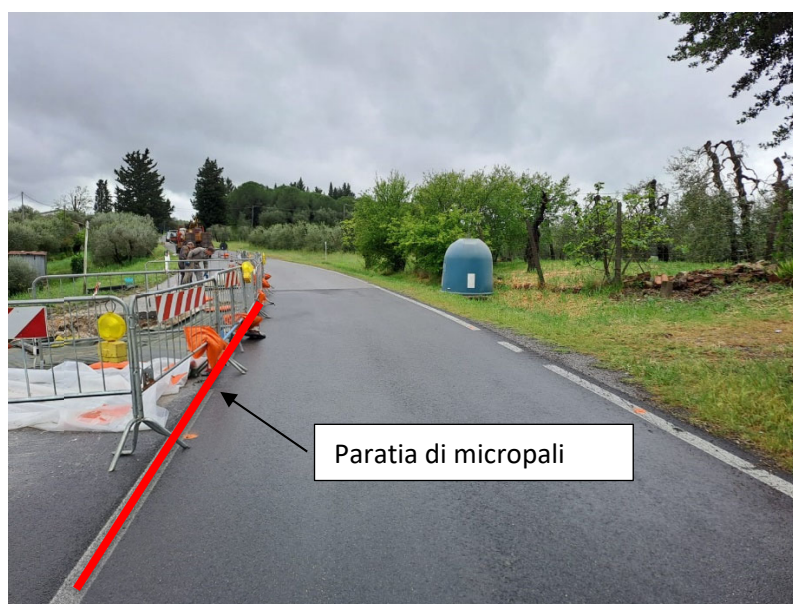
Posizionamento della paratia provvisoria di micropali
