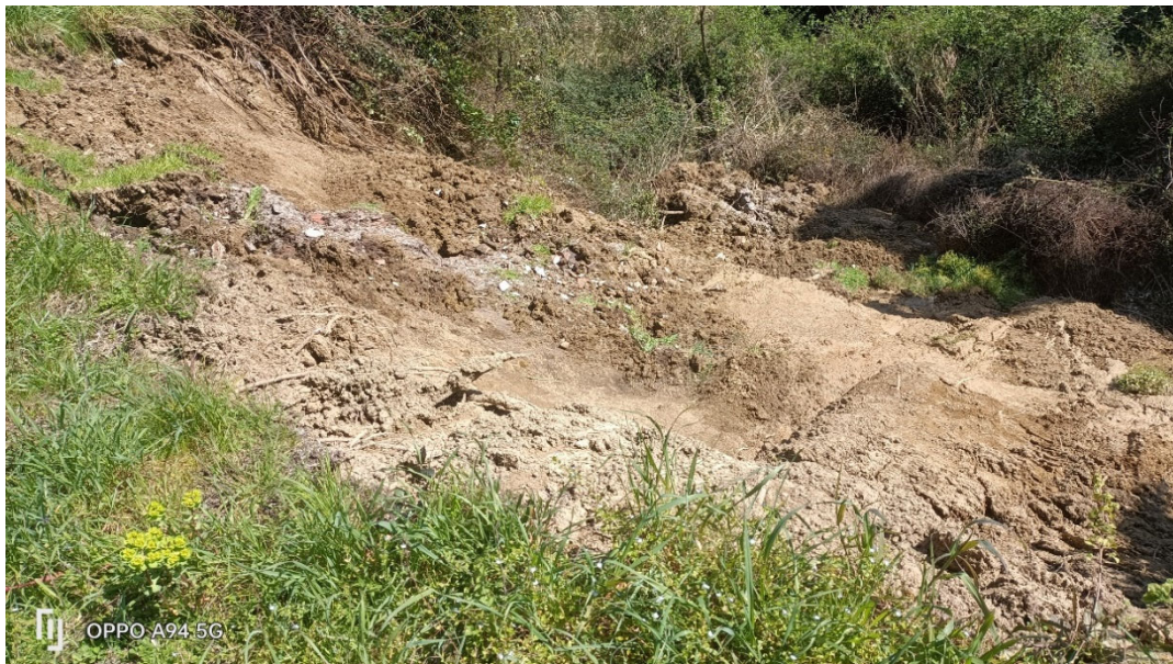
Area del calanco esistente dove si deposita il materiale mobilizzato della frana
