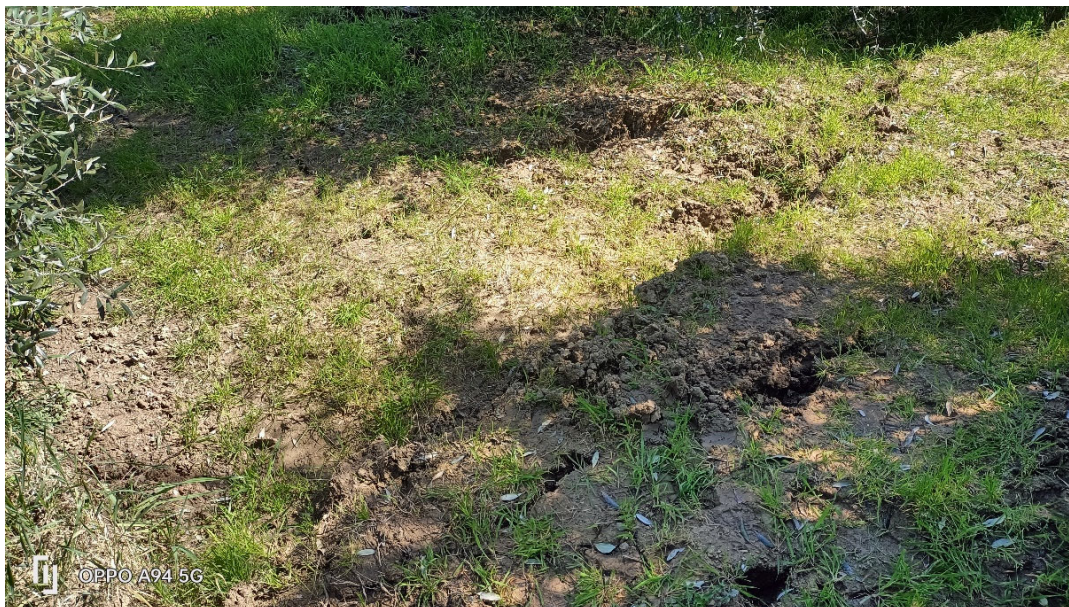
Fessurazioni attive lungo il profilo della corona di frana
