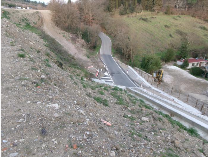
Foto 1 - Vista da Sud dell'area di intervento.
