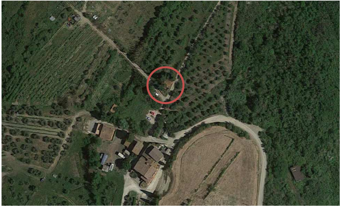
Foto aerea con individuazione edificato di Combertoli e area di intervento
