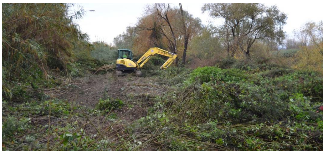
Fig. 8: Rimozione della vegetazione con mezzo meccanico
