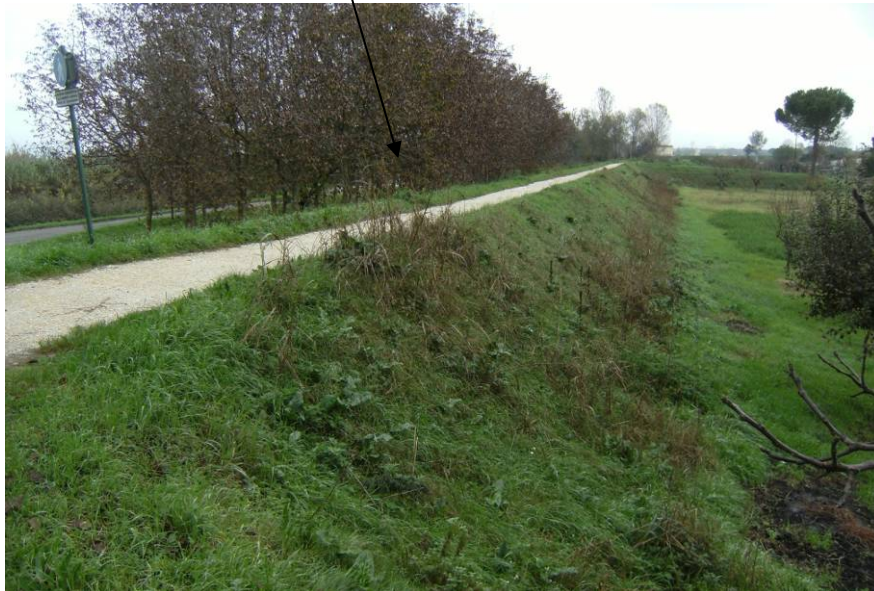
Fig. 4: Argine lungo l'Arno indicato al Punto 1
