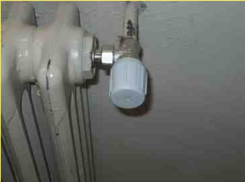
E' stato inoltre richiesto un quantitativo adeguato di **termostati termomeccanici** che consentano la regolazione della temperatura nelle singole aule dell'edificio al fine di ridurre lo spreco energetico.
