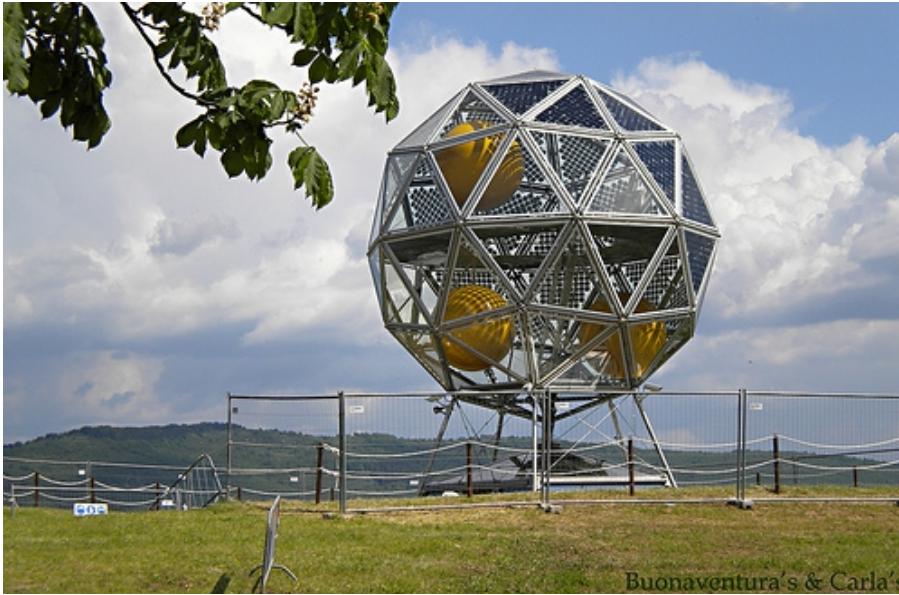
Centrale Fotovoltaica di nuova generazione
