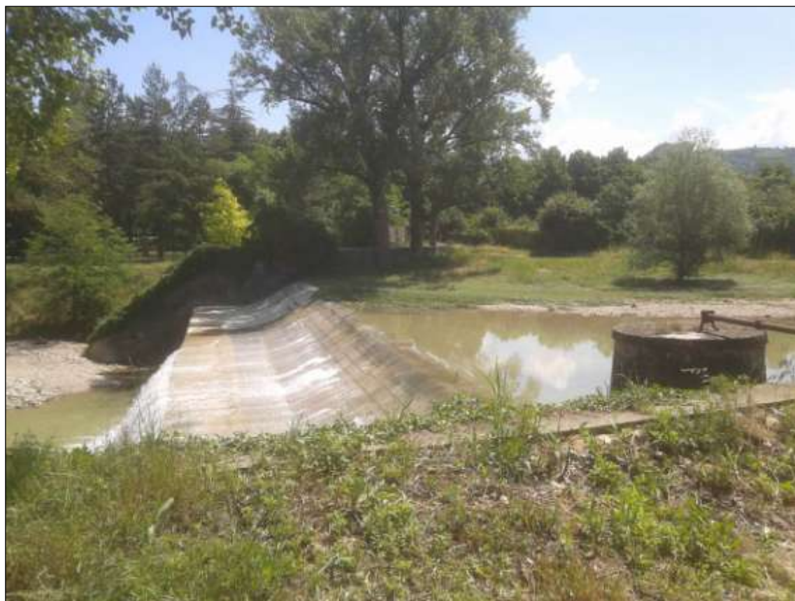
Figura 1-7. Traversa esistente sul torrente Pesa, foto da sponda idrografica sinistra.
