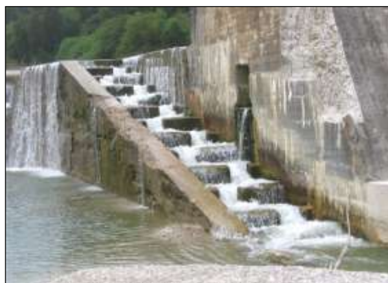
Figura 3-7: Esempio di scala di risalita per pesci.
