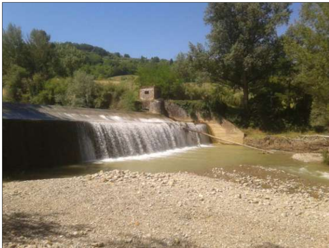
Figura 1-6. Traversa esistente sul torrente Pesa, foto da sponda idrografica destra.
