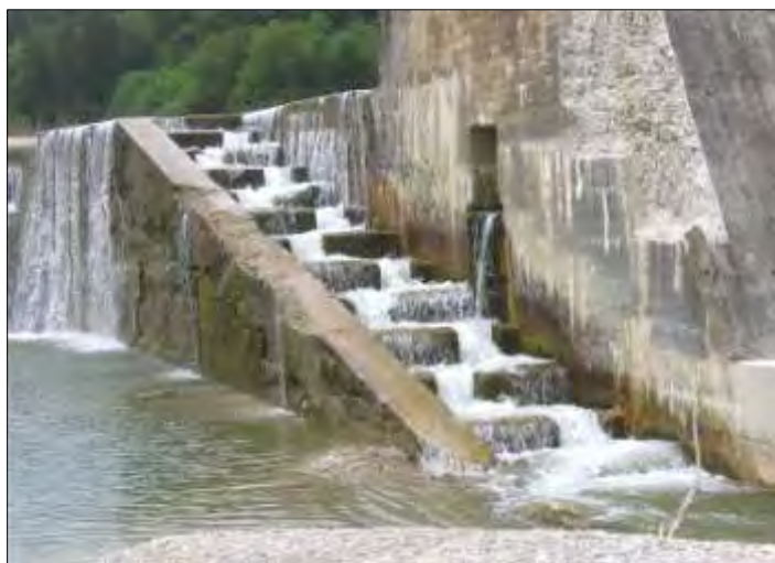
Figura 20: esempio di scala di risalita per pesci.
