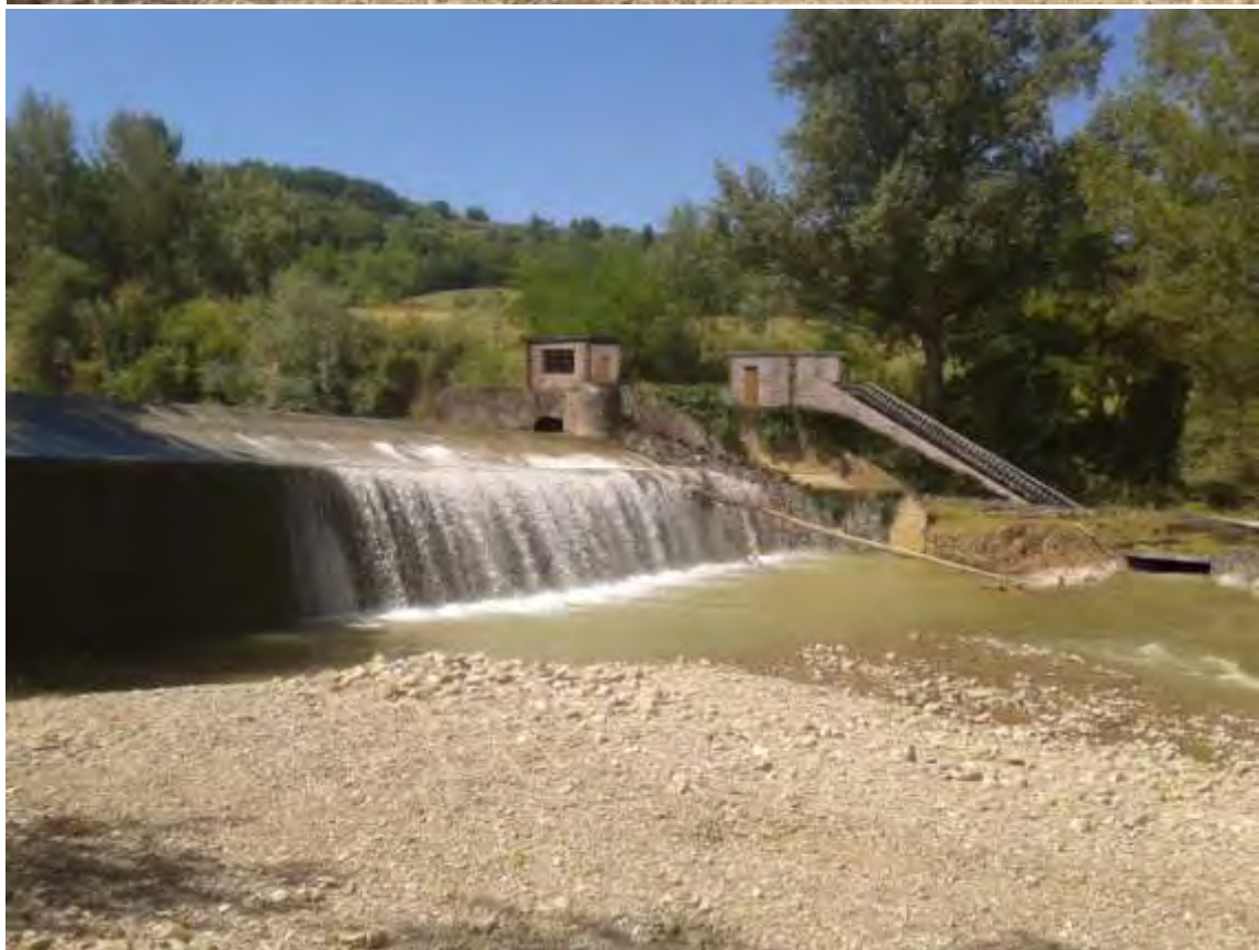
Figura 21. Fotoinserimento delle opere in progetto viste dalla sponda destra del torrente. La scala di risalita è stata fatta scaricare a valle del canale di restituzione per evitare il richiamo dell'ittiofauna dentro la turbina.
