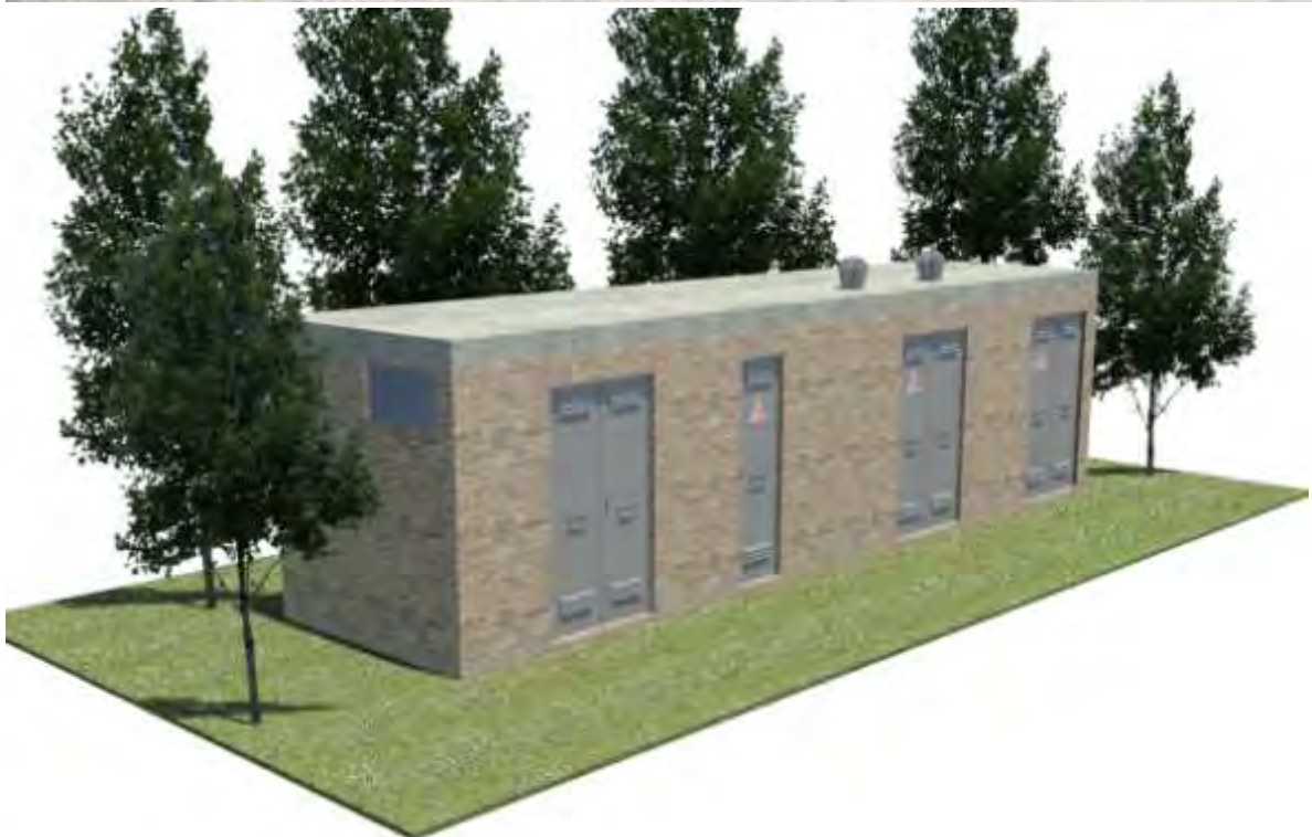
Figura 22. Locale di consegna dell'energia prodotta (in basso) da realizzarsi con rivestimento in mattoni per richiamare gli edifici con la medesima funzione presenti nell'area.
