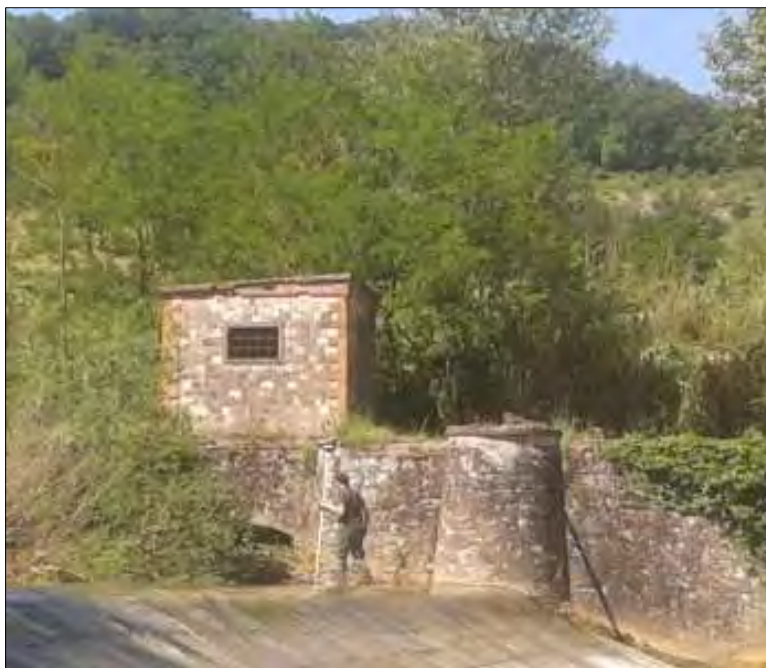
Figura 13: fabbricato da utilizzare come locale di controllo, manovra e misura.
