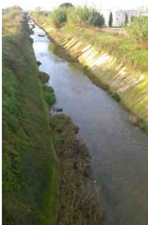
Figure - Canale di Montalvo nel tratto a monte con sponde di cemento e nel successivo tratto con sponde in terra.
