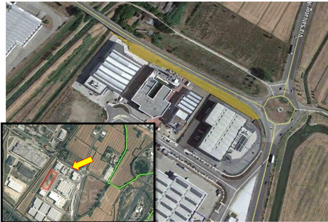
Figura - La freccia indica l'area umida situata sul lato nord-est del complesso degli edifici industriali in continuità con il fosso di Montalvo. In rosso il primetro dell'area di progetto. In giallo dettaglio dell'area di cui si propone la protezione per gli Anfibi
