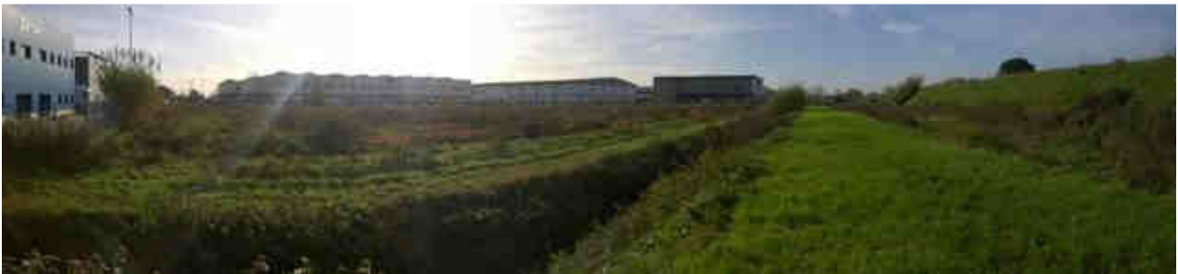
Fig. 7 - Panoramica vista da Nord
